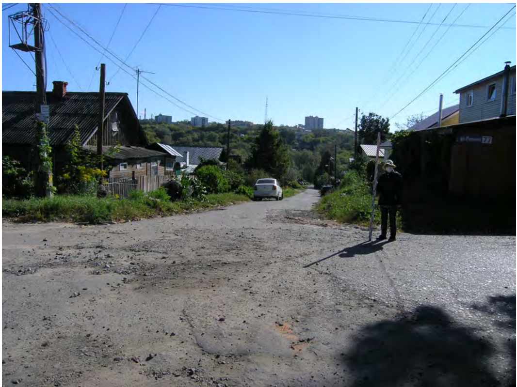
Илл. 5. Чебоксары «Новая Богданка», 2020. Общий вид на обследованный участок. Точка фотосъемки 1. Вид с СЗ
