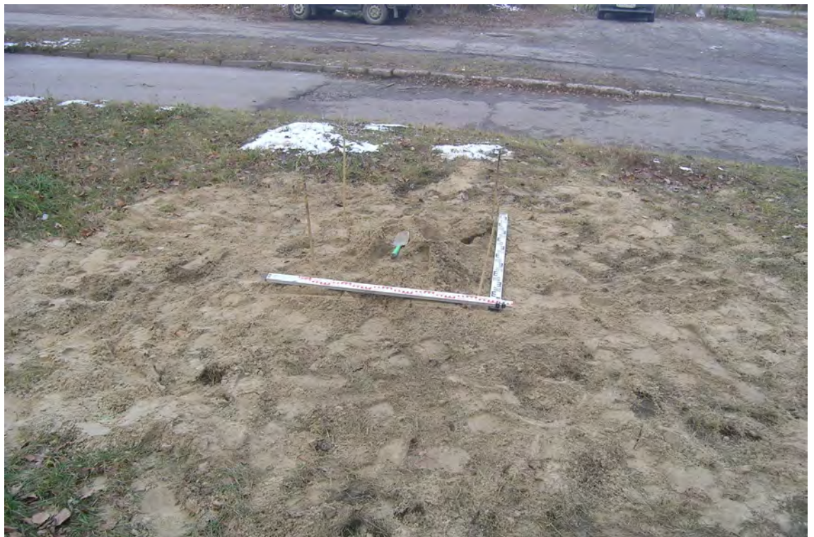
Рис. 60. Шурф 3. После рекультивации. Вид с юга.
