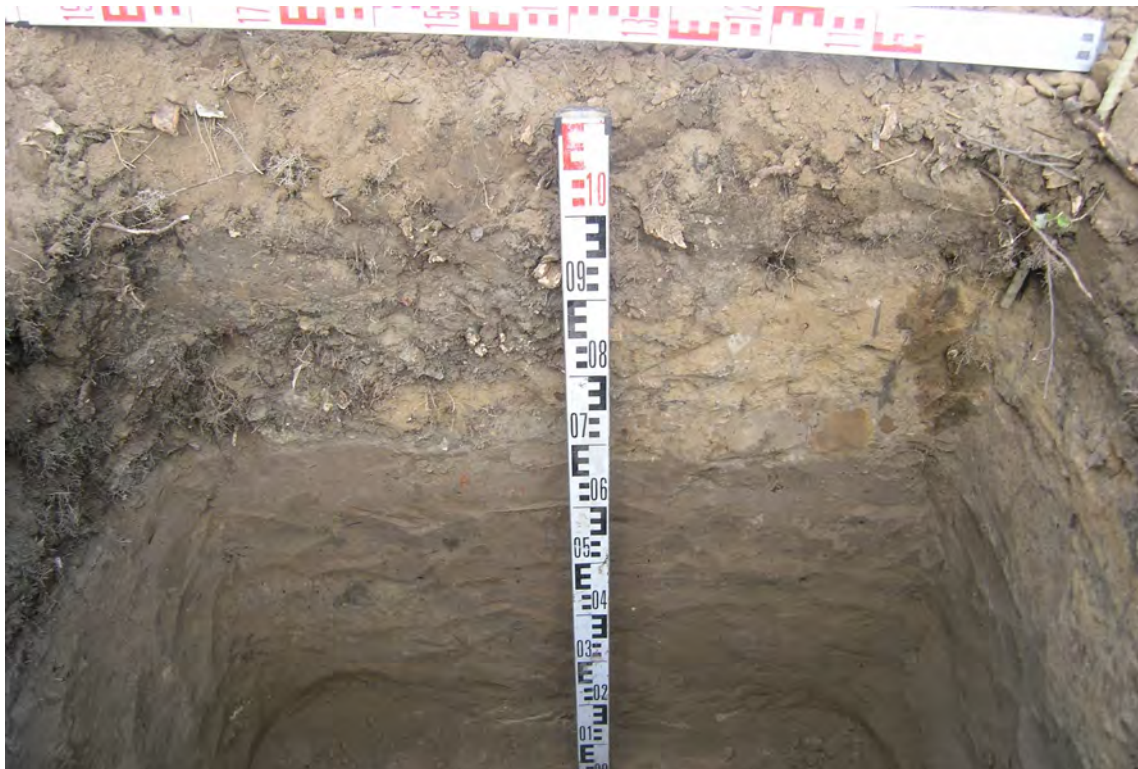
Рис. 55. Шурф 2. Северная стенка.
