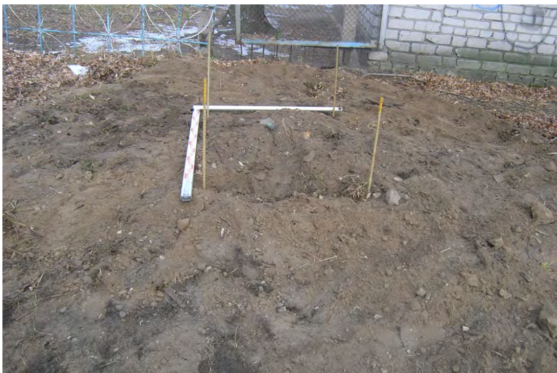
Рис. 56. Шурф 2. После рекультивации. Вид с юга.
