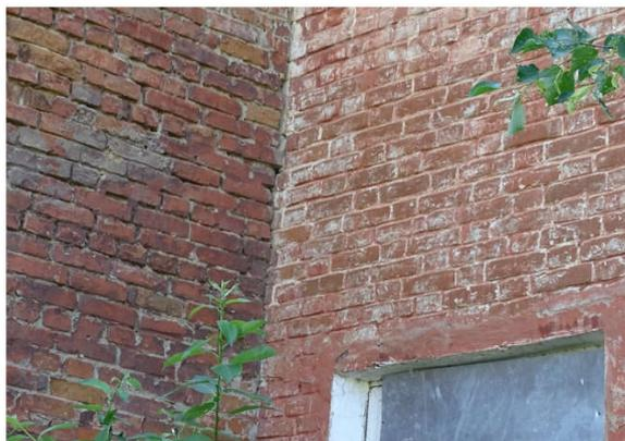
Фото 4.1.1 Фасады здания. Стены выполнены из красного кирпича на цементно-известковом растворе. Видны следы высолов, замачивания цокольной части, вымывания швов кладки
