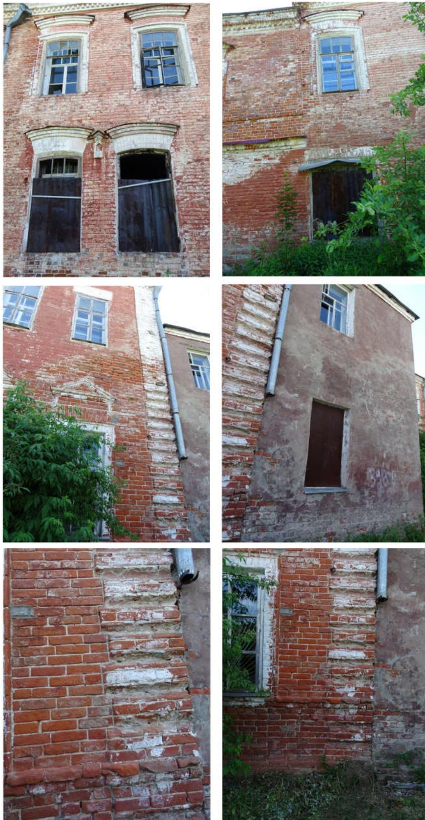
Фото 4.1. 2 Фасады здания. Стены здания выполнены из красного кирпича на цементно-известковом растворе. Видны следы высолов, следы разрушения лицевой поверхности кирпича, каверны, вымывания раствора из швов кладки, плесень, мох.
