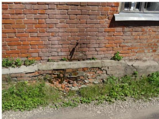
Фото 4.1.3 Фасады. Участки кирпичной кладки имеют механические повреждения, сколы, вымывания кирпичной кладки в уровне цоколя, выщелачивание кирпича, каверны. Отмостка бетонная имеет трещины, примыкание к зданию нарушено.
