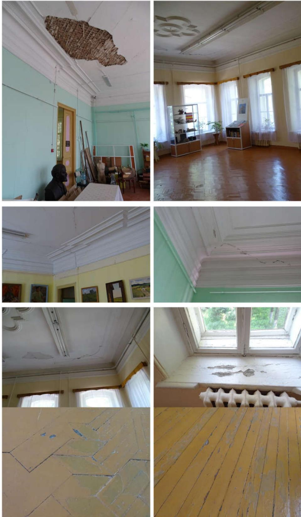
Фото 4.1.5. Интерьеры. Штукатурка по дранке потолков имеет провисы, следы замачивания от протечек кровли, трещины в лепных тягах на стенах и потоках, Покрытие полов из сборной паркетной доски и дощатого покрытия со следами неплотностей, шелушения окрасочных слоев.
