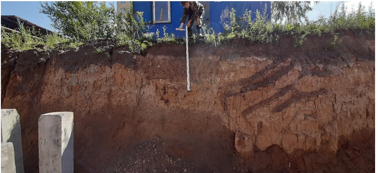
Ил. 5. Зачистка 1. Вид с запада.
