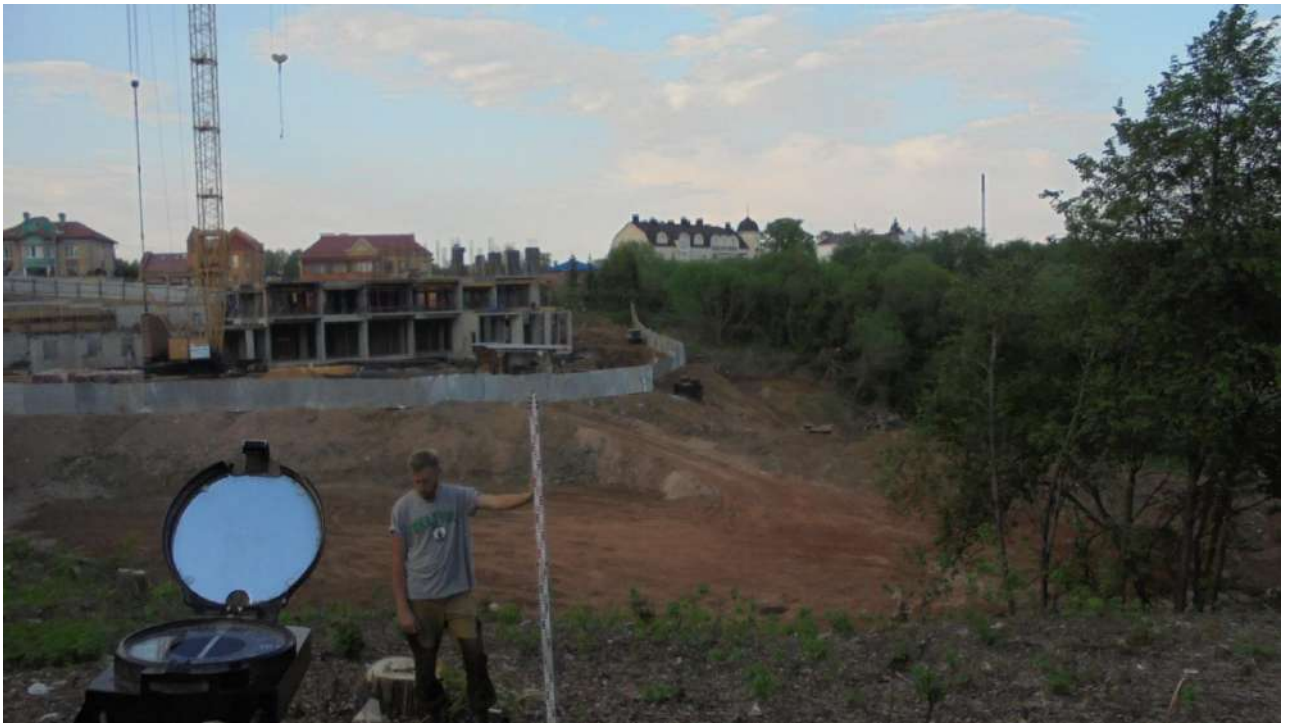
Илл. 37. Точка фотофиксации 3, вид с Ю.
