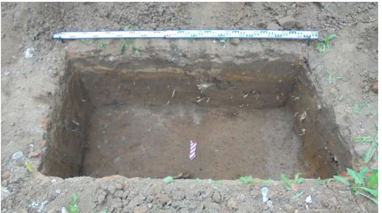
Илл. 11. Шурф 2 общий вид с С.
