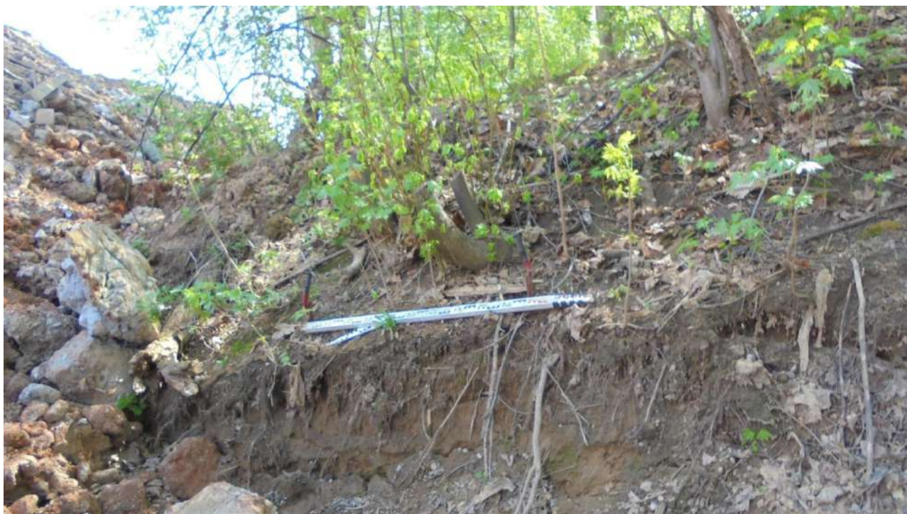
Илл. 65. Зачистка 5 перед началом работ. Вид с СЗ.
