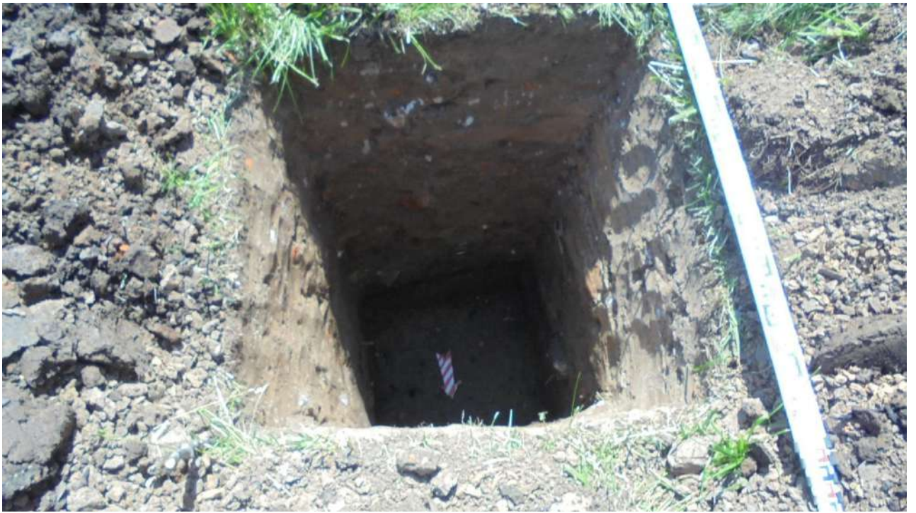
Илл. 75. Шурф 7 общий вид с С.
