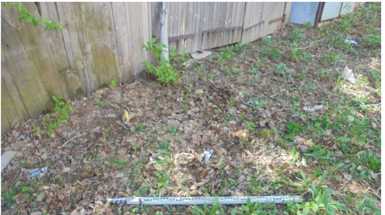
Илл. 60. Шурф 4 перед началом работ. Вид с С.
