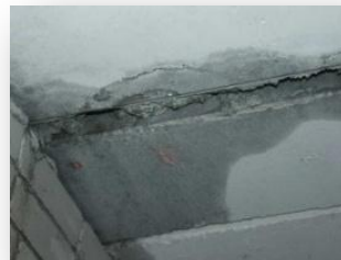
Протечки (конденсат) на потолке верхнего этажа
