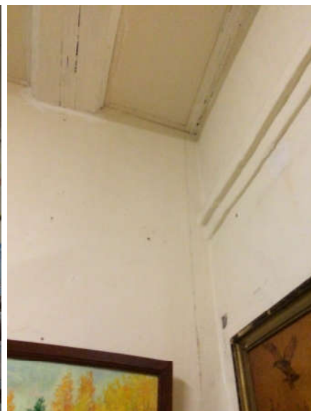
Фото 4.1.1 Состояние внутренних помещений здания. Следы шелушения окрасочных слоев. Электропроводка в здании выполнена с нарушением требований ПЭУ.
