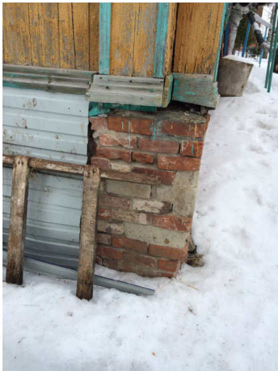
Фото 4.1. 9 Фасад здания. Обшивка стен из деревянной доски. Цокольная часть здания выполнена из керамического кирпича, угловые пилоны имеют трещины, местами переложены без учета перевязки швов. Продухи забиты кирпичом, монтажной пеной, ветошью.
