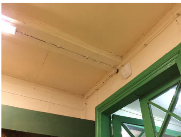
Фото 4.1. 2 Внутренние интерьеры. Состояние потолков не удовлетворительное. Повсеместные следы протечек с кровли здания. Волосяные трещины штукатурных слоев. Следы плесени.
