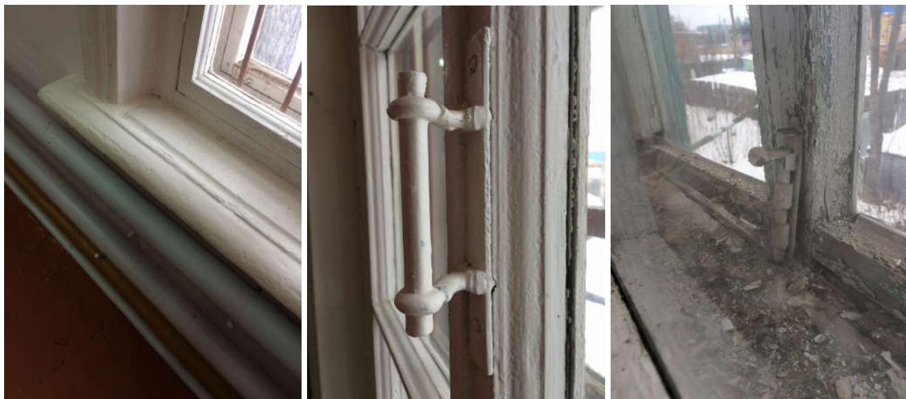
Фото 4.1. 4 Оконные блоки в отдельных переплетах, деревянные. Местами внутренние оконные блоки заменены на глухие остекленные рамы. Состояние оконных блоков не удовлетворительное – деревянные переплеты подвержены гниению, рассохлись, шелушение окрасочных слоев. Оконная фурнитура деформирована, практически отсутствует. На отдельных оконных створках сохранились исторические образцы. Подоконные доски деревянные профилированные, местами рассохлись.
