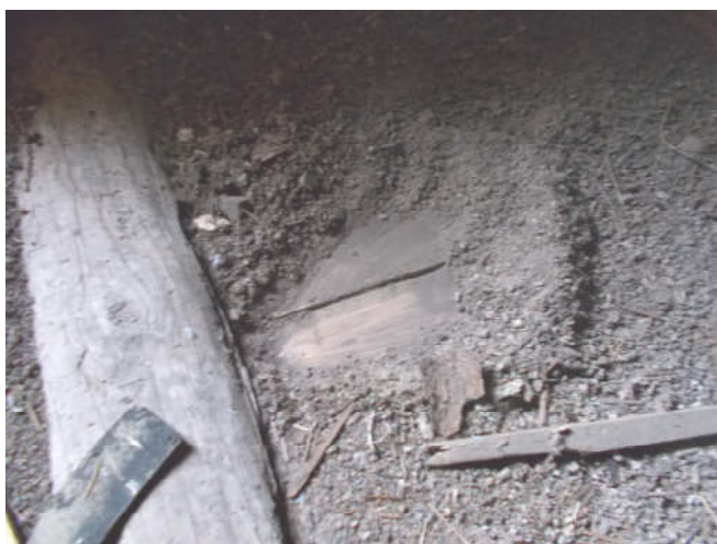
Фото 4.1. 8 Чердачное перекрытие. Следы гниение и грибковые поражения на отдельных участка балок перекрытия. Утепление чердачного перекрытия выполнено по доскам наката с засыпкой шлаком толщиной от 10 до 12 см.
