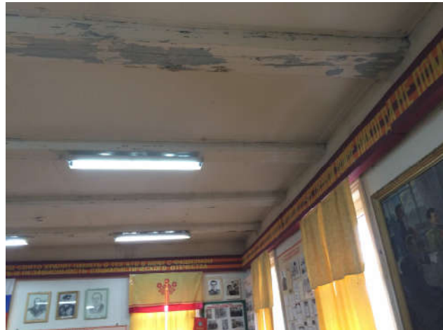
Фото 4.1. 2 Внутренние интерьеры. Состояние потолков не удовлетворительное. Повсеместные следы протечек с кровли здания. Волосяные трещины штукатурных слоев. Следы плесени.
