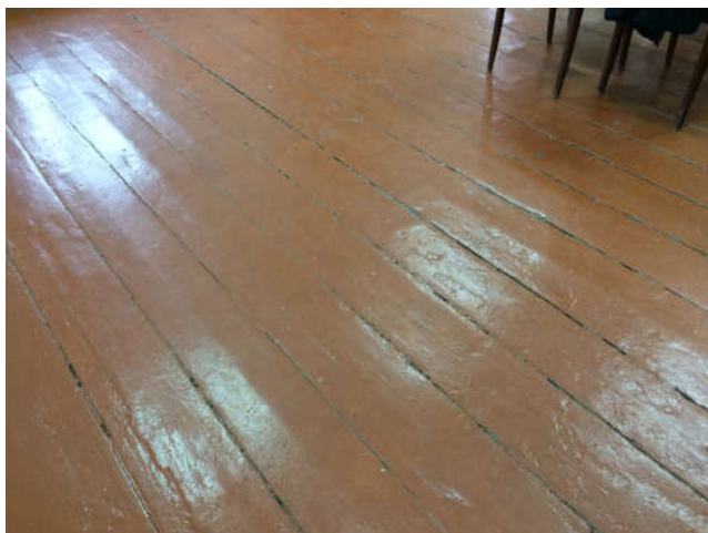
Фото 4.1.3 Фрагменты интерьеров здания. Конструкции полов: деревянные по деревянным лагам, покрытие выполнено из досок не шпунтованных окрашены масляными составами. Состояние не удовлетворительное, требуют ремонта.
