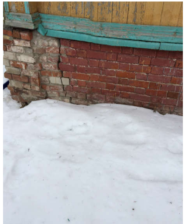
Фото 4.1. 9 Фасад здания. Обшивка стен из деревянной доски. Цокольная часть здания выполнена из керамического кирпича, угловые пилоны имеют трещины, местами переложены без учета перевязки швов. Продухи забиты кирпичом, монтажной пеной, ветошью.
