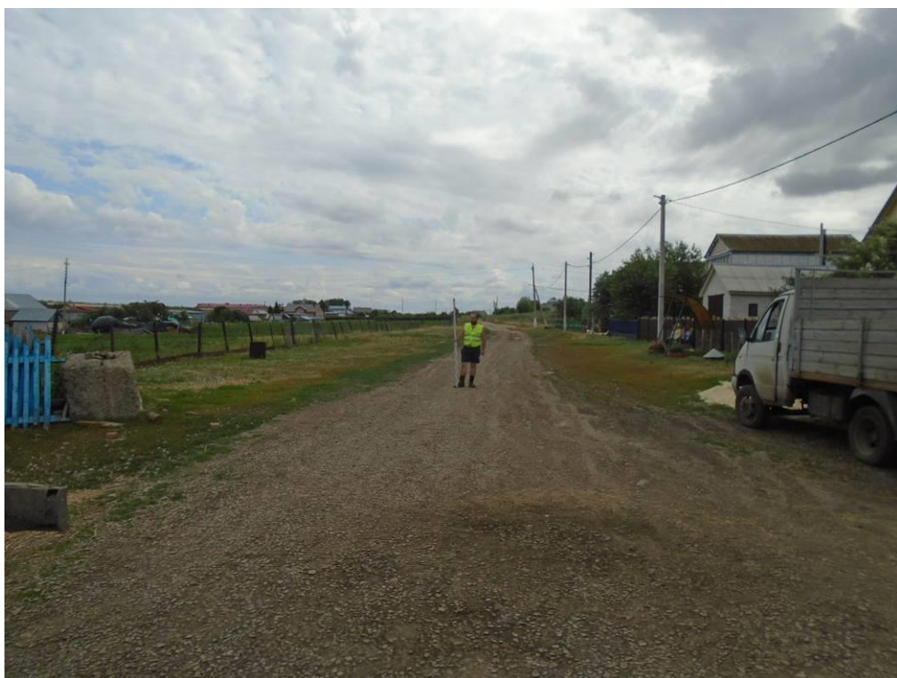
Рис. 21. Объект «Строительство автомобильной дороги по улицам Новая и Северная, в с. Байдеряково Яльчикского района Чувашской Республики». Общий вид местности вдоль объекта. Точка фотофиксации №6. Участок №1. Вид с З.
