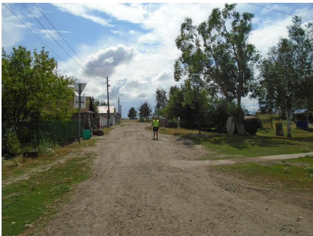
Рис. 37. Объект «Строительство автомобильной дороги по улицам Новая и Северная, в с. Байдеряково Яльчикского района Чувашской Республики». Общий вид местности вдоль объекта. Точка фотофиксации №15. Участок №2. Вид с ССВ.
