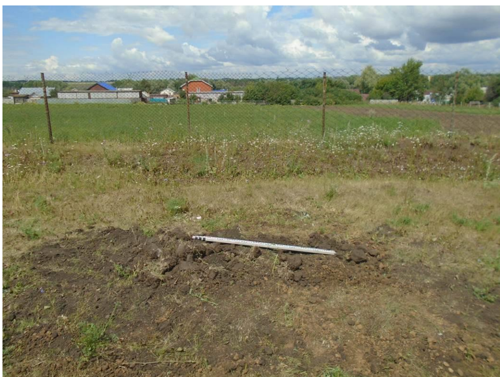
Рис. 48. Объект «Строительство автомобильной дороги по улицам Новая и Северная, в с. Байдеряково Яльчикского района Чувашской Республики». Рекультивация рекогносцировочного шурфа № 2. Вид с Ю.
