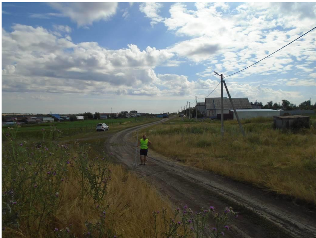
Рис. 19. Объект «Строительство автомобильной дороги по улицам Новая и Северная, в с. Байдеряково Яльчикского района Чувашской Республики». Общий вид местности вдоль объекта. Точка фотофиксации №5. Участок №1. Вид с З.
