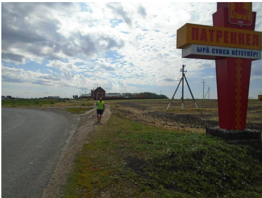
Рис. 11. Объект «Строительство автомобильной дороги по улицам Новая и Северная, в с. Байдеряково Яльчикского района Чувашской Республики». Общий вид местности вдоль объекта. Точка фотофиксации №1. Участок №1. Вид с ЗСЗ.
