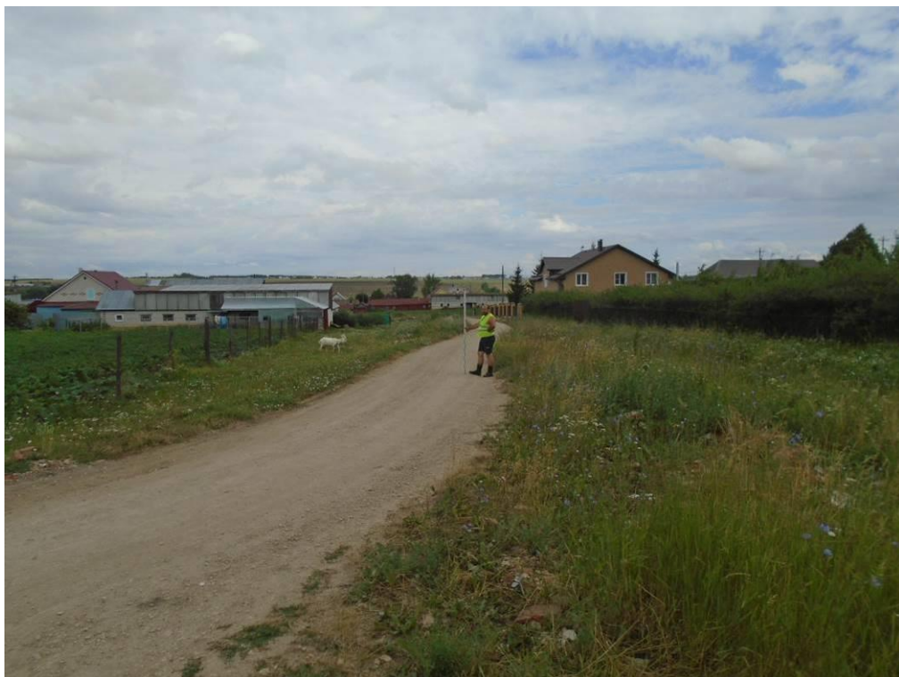
Рис. 25. Объект «Строительство автомобильной дороги по улицам Новая и Северная, в с. Байдеряково Яльчикского района Чувашской Республики». Общий вид местности вдоль объекта. Точка фотофиксации №8. Участок №1. Вид с ЮЮЗ.
