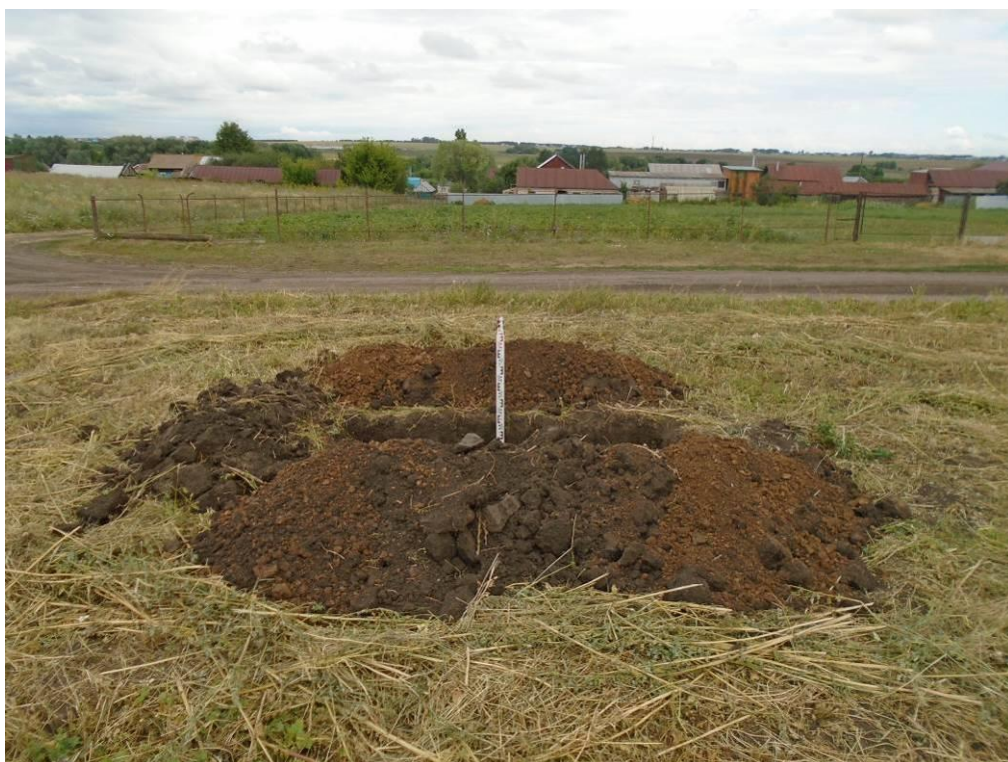
Рис. 41. Объект «Строительство автомобильной дороги по улицам Новая и Северная, в с. Байдеряково Яльчикского района Чувашской Республики». Рекогносцировочный шурф № 1. Дальний план. Вид с Ю.
