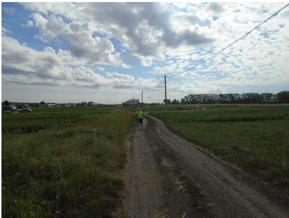
Рис. 15. Объект «Строительство автомобильной дороги по улицам Новая и Северная, в с. Байдеряково Яльчикского района Чувашской Республики». Общий вид местности вдоль объекта. Точка фотофиксации №3. Участок №1. Вид с З.
