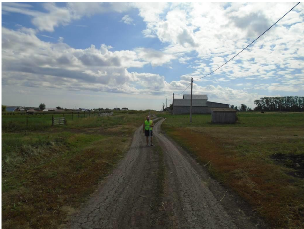
Рис. 17. Объект «Строительство автомобильной дороги по улицам Новая и Северная, в с. Байдеряково Яльчикского района Чувашской Республики». Общий вид местности вдоль объекта. Точка фотофиксации №4. Участок №1. Вид с З.
