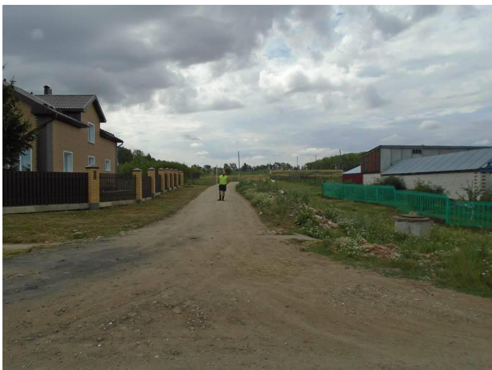
Рис. 26. Объект «Строительство автомобильной дороги по улицам Новая и Северная, в с. Байдеряково Яльчикского района Чувашской Республики». Общий вид местности вдоль объекта. Точка фотофиксации №9. Участок №1. Вид с ССВ.
