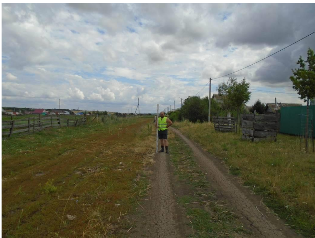
Рис. 30. Объект «Строительство автомобильной дороги по улицам Новая и Северная, в с. Байдеряково Яльчикского района Чувашской Республики». Общий вид местности вдоль объекта. Точка фотофиксации №11. Участок №2. Вид с З.
