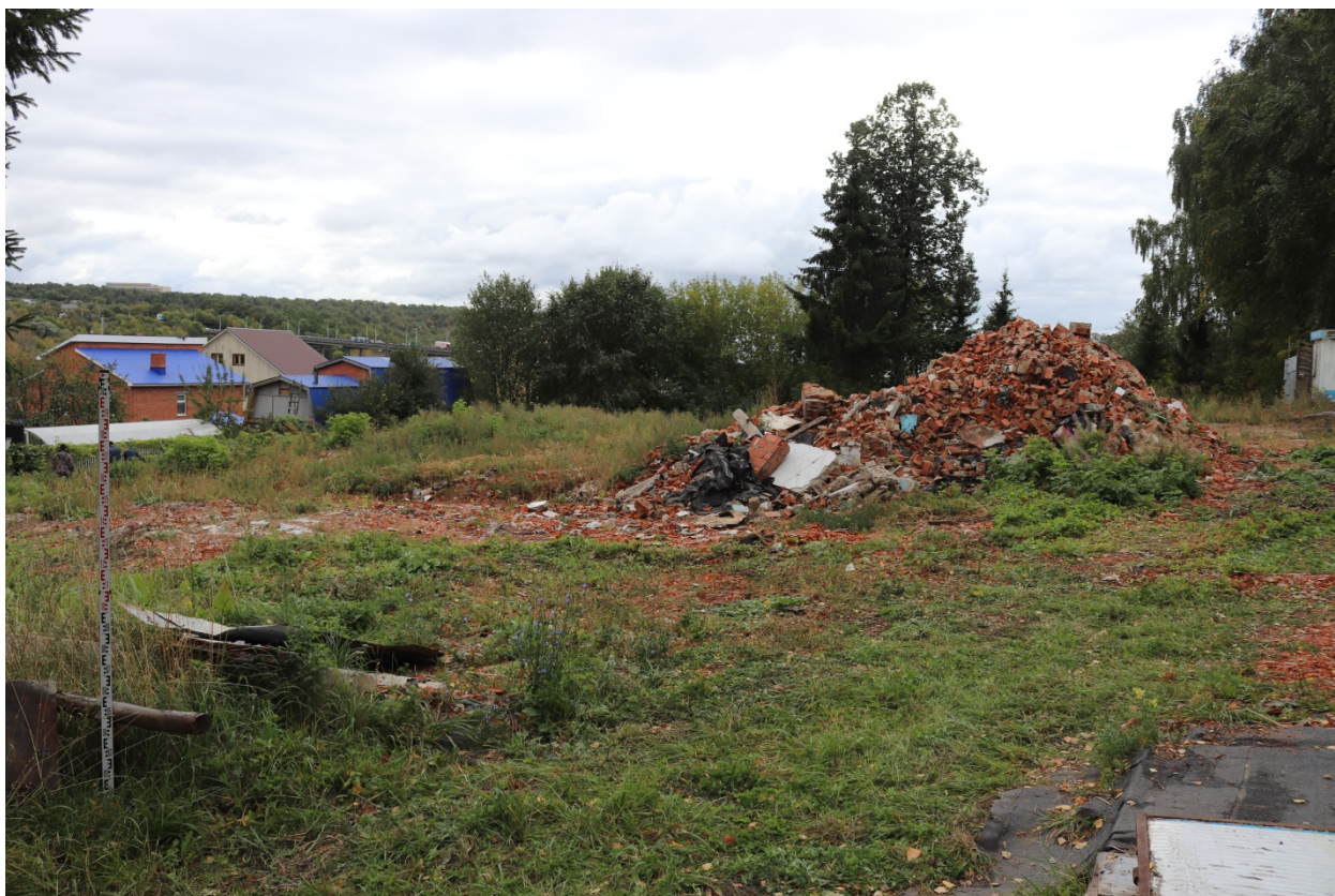
Рис. 22. «Многоэтажный жилой дом по адресу: Чувашская Республика - Чувашия, город Чебоксары, ул. Репина...». Фото участка обследования. Точка фотофиксации №6. Вид с ССЗ.
