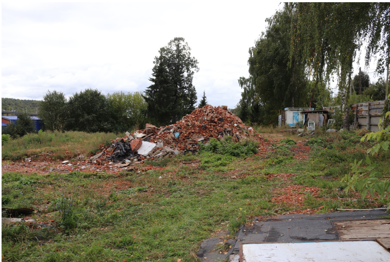
Рис. 23. «Многоэтажный жилой дом по адресу: Чувашская Республика - Чувашия, город Чебоксары, ул. Репина...». Фото участка обследования. Точка фотофиксации №6. Вид с С.
