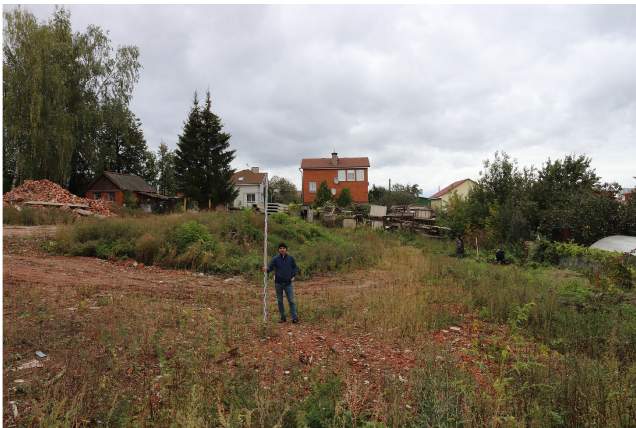
Рис. 18. «Многоэтажный жилой дом по адресу: Чувашская Республика - Чувашия, город Чебоксары, ул. Репина...». Фото участка обследования. Точка фотофиксации №4. Вид с Ю.
