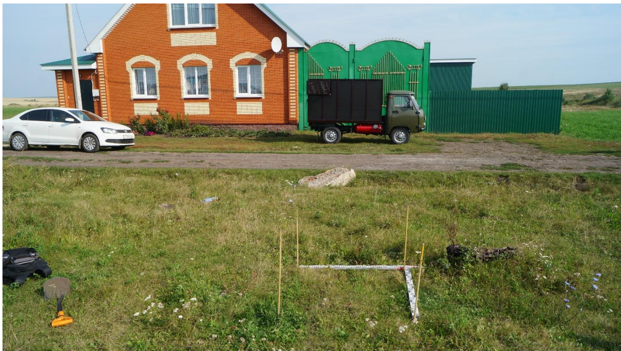
Илл. 19. Участок обследования в с. Токаево. Шурф 2. Фото разбивки. Вид с юга.
