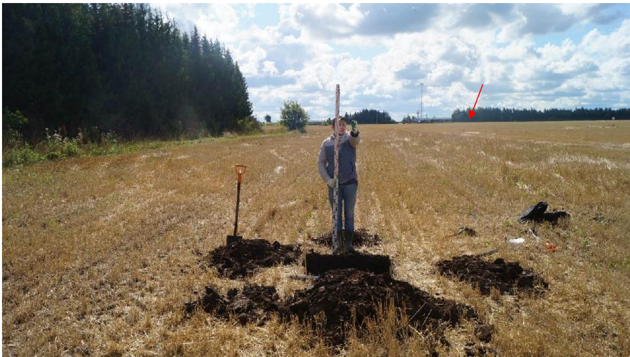
Рис. 52. Рекогносцировочный шурф № 5. Общий вид на шурф. Вид с севера. На заднем плане автомобильная дорога Аликово-Ядрин (отм. стрел.)
