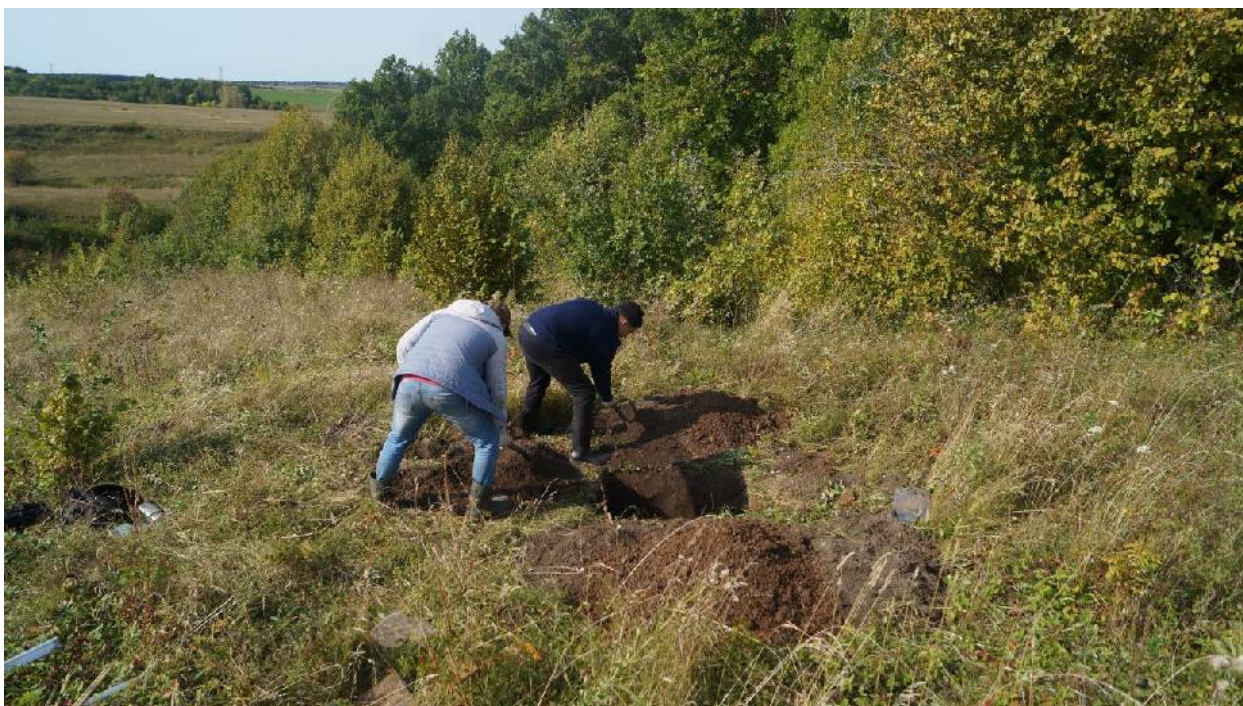
Рис. 107. Рекогносцировочный шурф № 12. Процесс засыпки. Вид с востока. На заднем плане овражно-балочная система в истоках р. Сирикли
