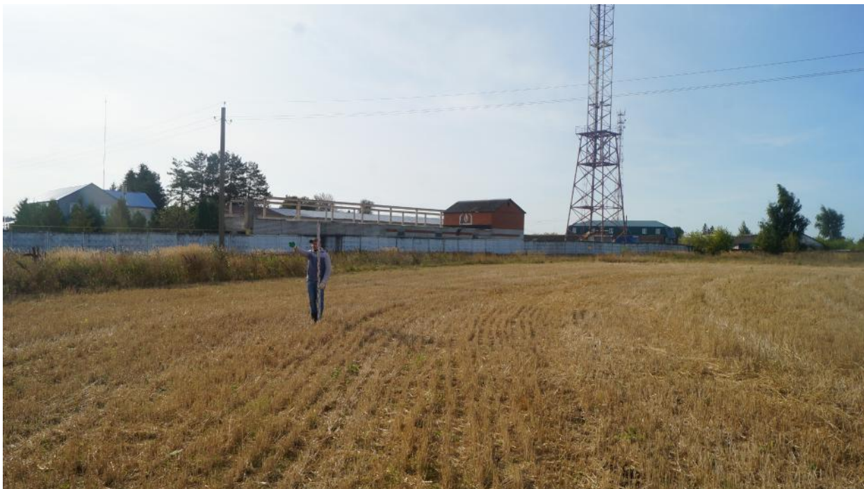
Рис. 6. Общий вид на проектируемый участок работ. Юго-восточная часть участка. Вид с севера. На плане Филиал АО «Газпром газораспределение Чебоксары»
