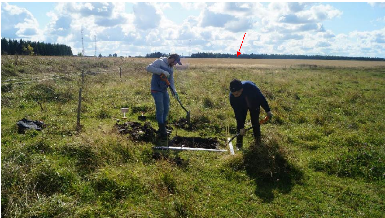
Рис. 56. Рекогносцировочный шурф № 6. Процесс закладки. Вид с севера. На заднем плане автомобильная дорога Аликово-Ядрин (отм. стрел.)
