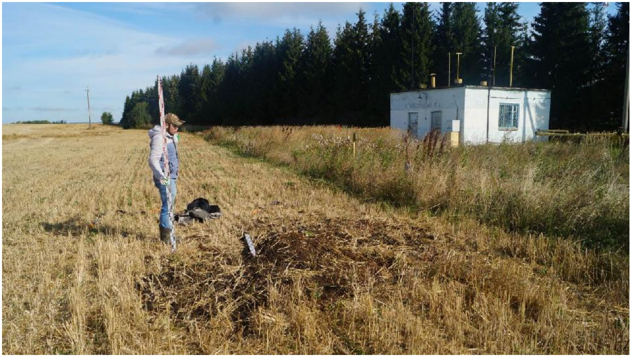
Рис. 22. Рекогносцировочный шурф № 1. Площадка шурфа после засыпки. Вид с юга. На плане газораспределительная станция
