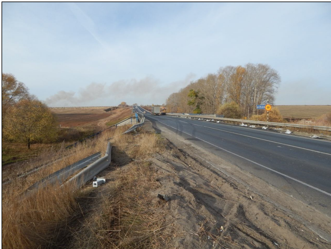
Илл. 12. Участок обследования. Точка съёмки 6. Вид с В.
