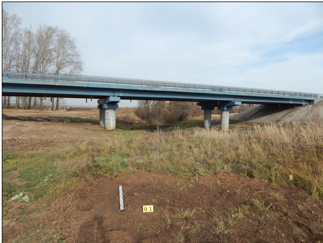
Илл. 34. Рекогносцировочный шурф № 1. Рекультивация. Вид с Ю.
