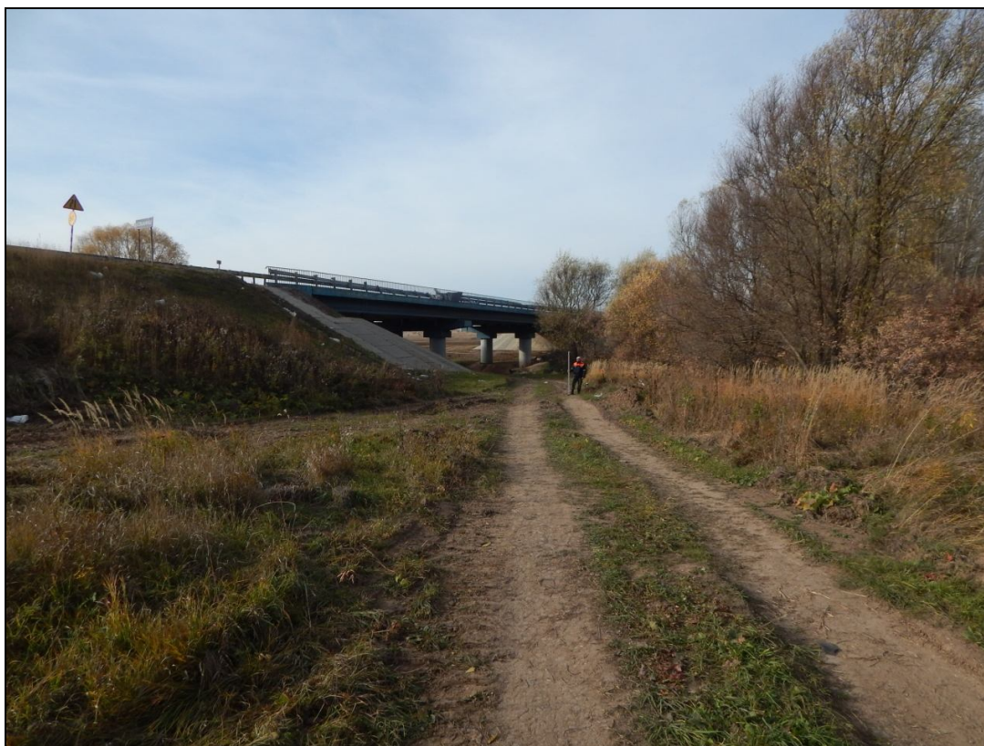
Илл. 17. Участок обследования. Точка съёмки 11. Вид с СВ.
