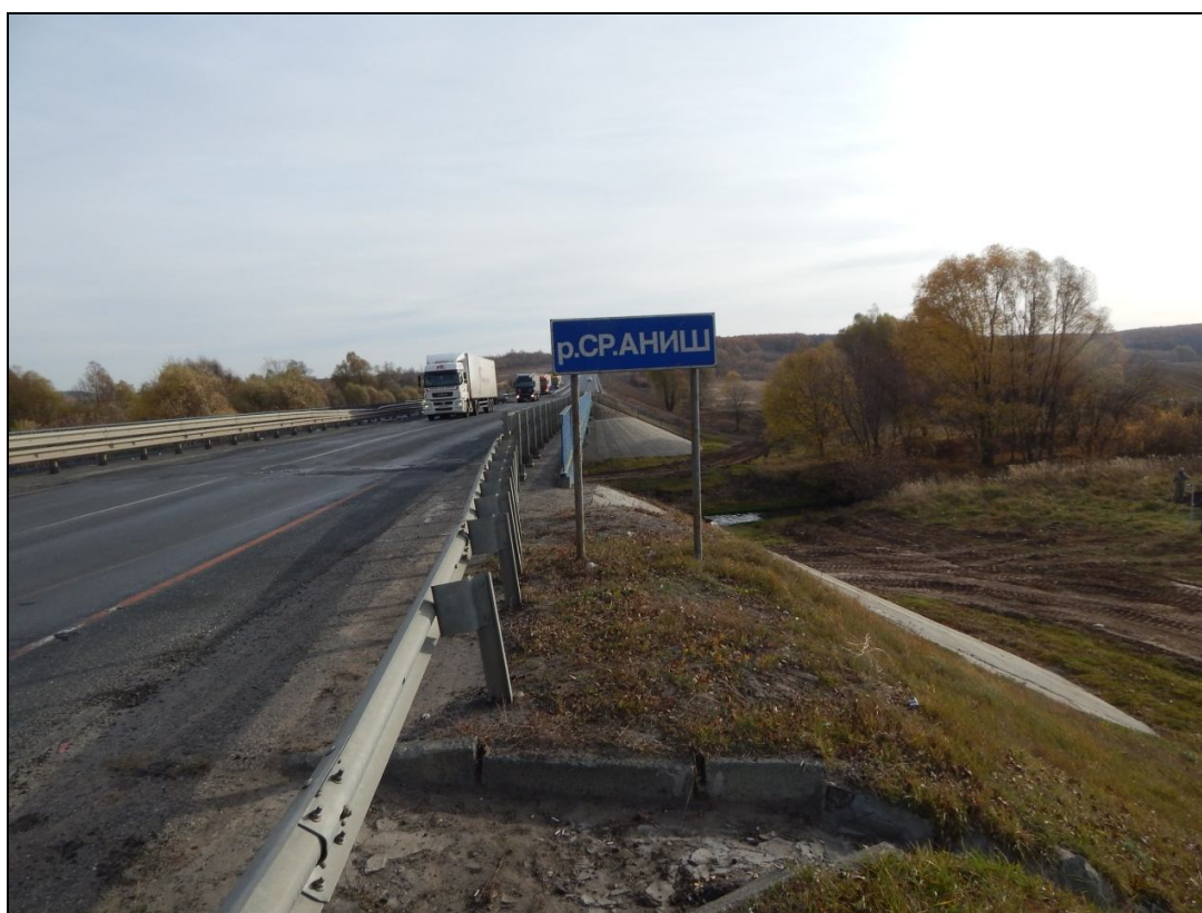
Илл. 25. Участок обследования. Точка съёмки 19. Вид с 3.
