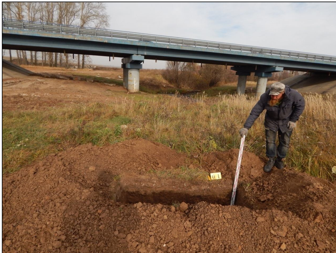
Илл. 32. Рекогносцировочный шурф № 1. Общий вид. Вид с Ю.
