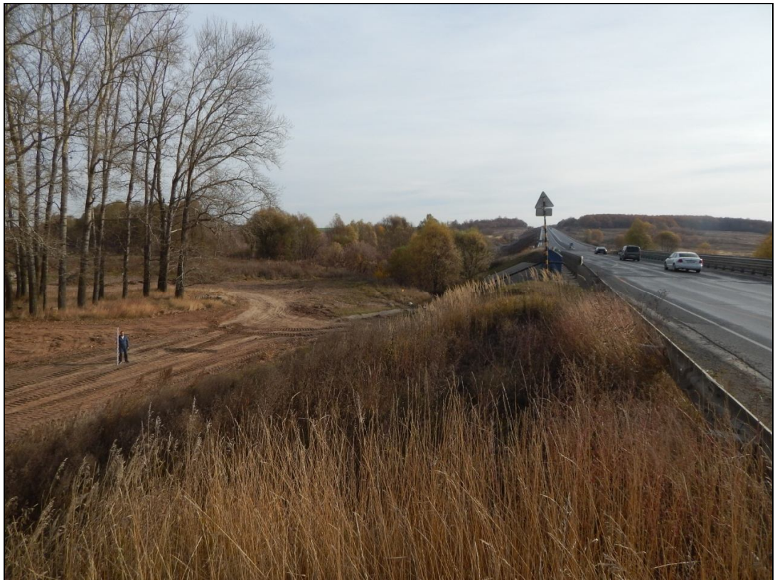
Илл. 23. Участок обследования. Точка съёмки 17. Вид с ЮЗ.
