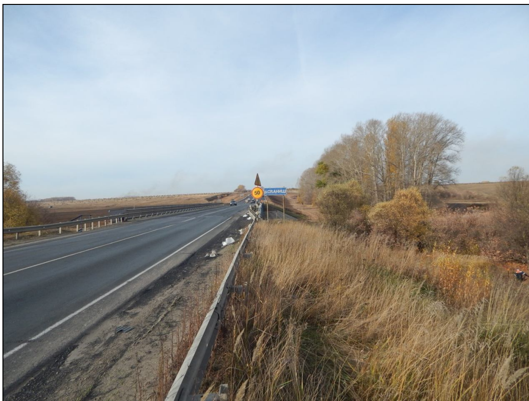
Илл. 13. Участок обследования. Точка съёмки 7. Вид с В.
