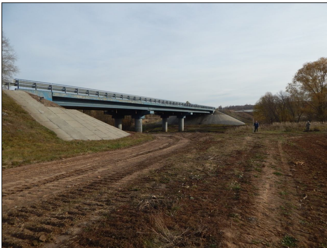
Илл. 29. Участок обследования. Точка съёмки 23. Вид с ЮЗ.
