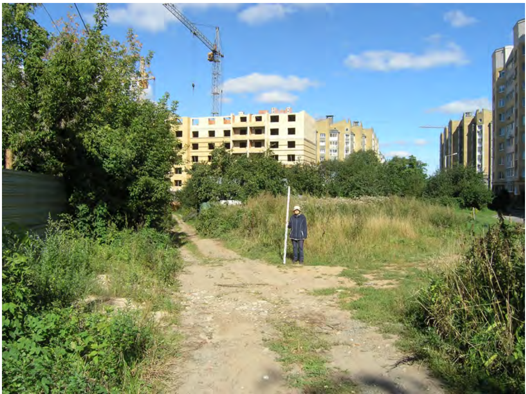
Илл. 12. Чебоксары, 2020, ул. Чапаева, поз. 13А и 13Б. Общий вид на обследованный участок. Точка фотосъемки 5. Вид с ЮЮВ.
