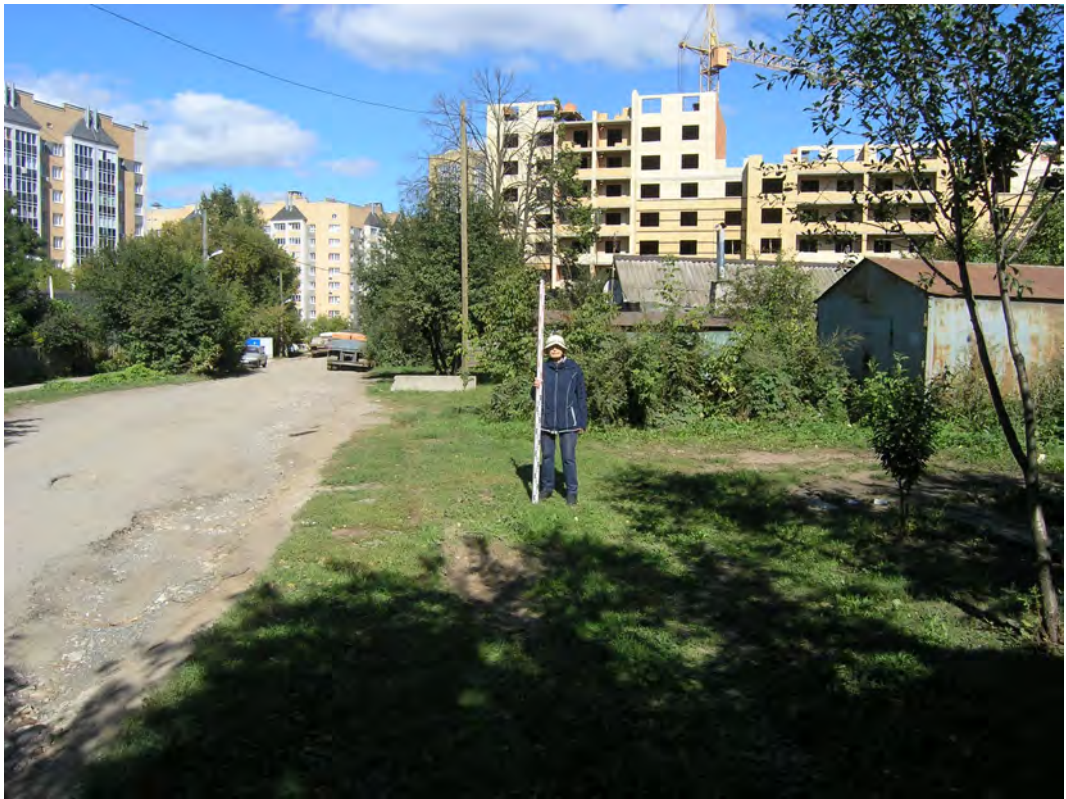
Илл. 5. Чебоксары, 2020, ул. Чапаева, поз. 13А и 13Б. Общий вид на обследованный участок. Точка фотосъемки 1. Вид с Ю.
