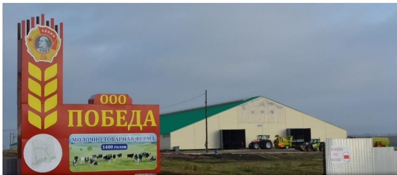
Строительство коровника ООО «Победа» 50 млн. руб.
