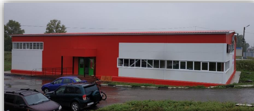
Строительство торгового объекта ИП Крыловым Б.В. 12 млн. руб.
