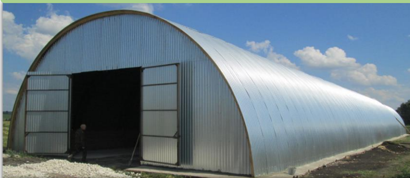
Строительство коровника КФХ Смирновым В.П. 8,2 млн. руб.
