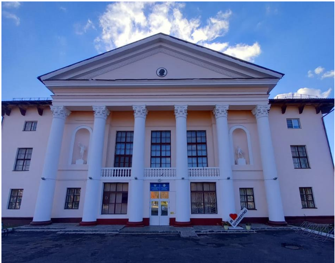
Фото № 4. Главный фасад объекта культурного наследия.
