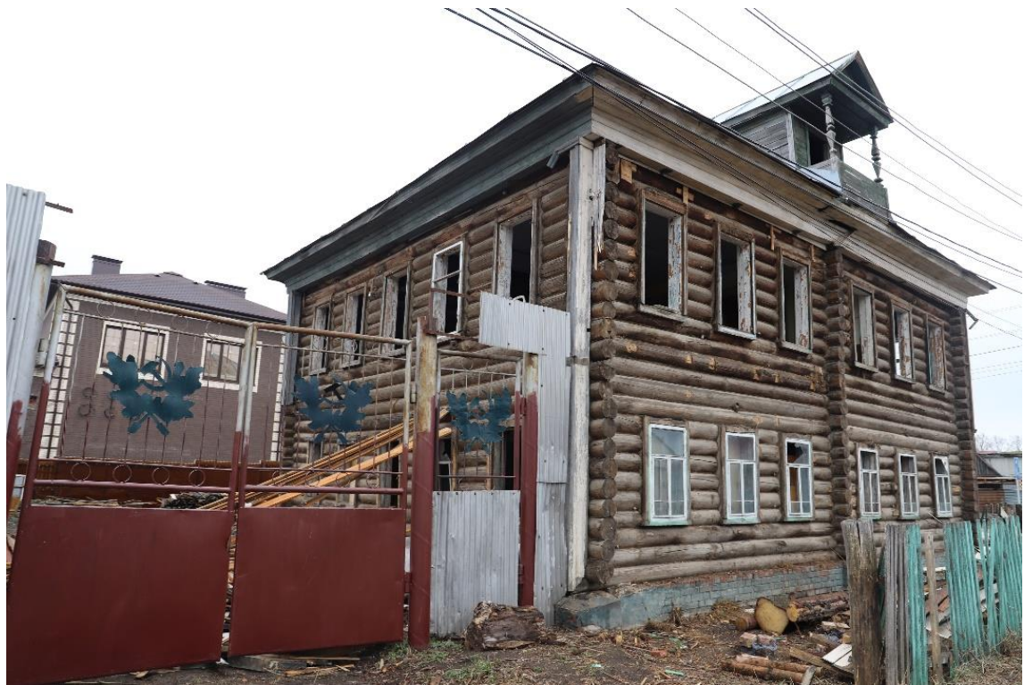
Вид с юго-востока (со стороны ул. Волжская)
