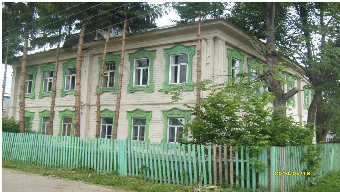
Состояние здания-памятника в 2010 г.
