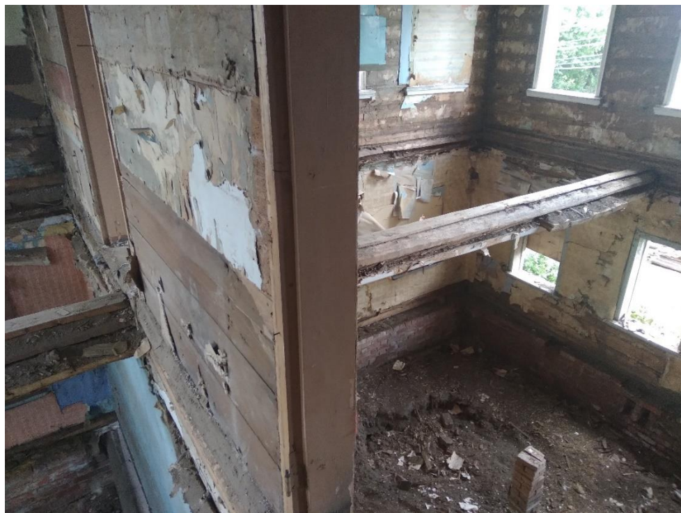
Северо-восточная и юго-восточная части дома с внутренней несущей стеной
