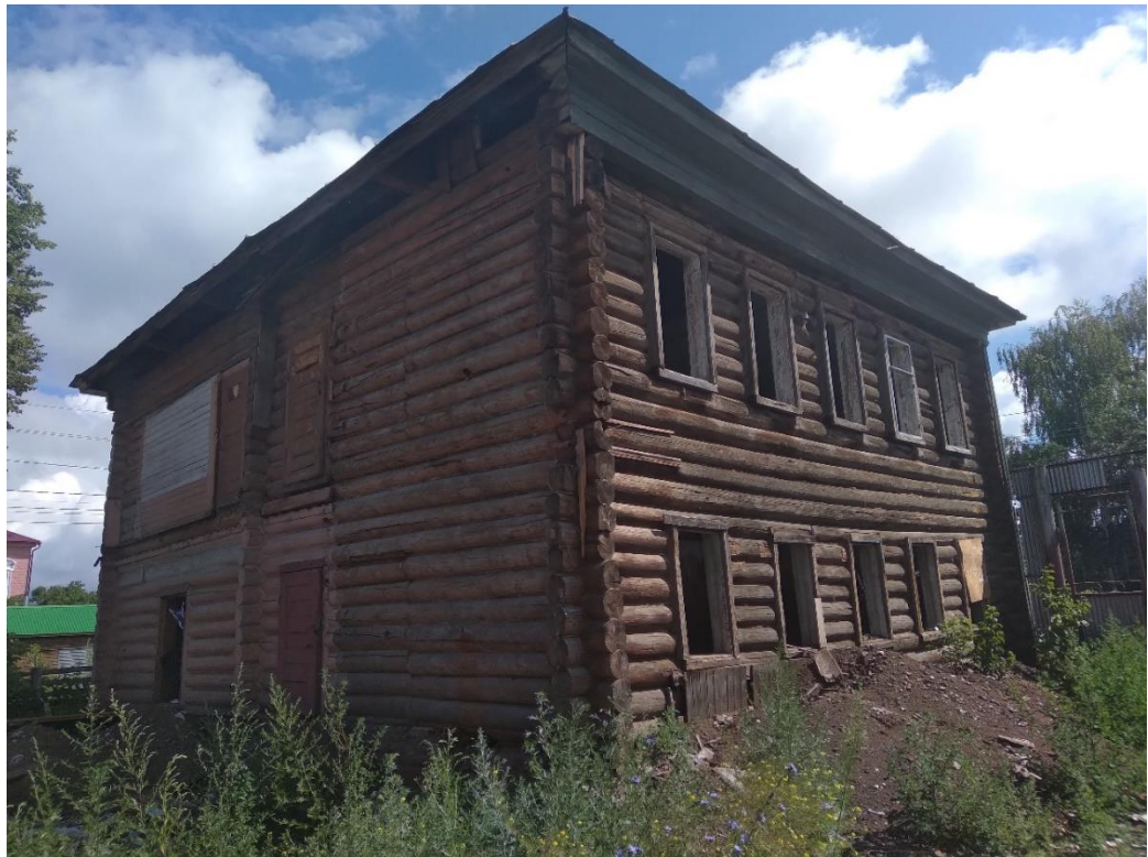
Вид с юго-востока (со двора)
