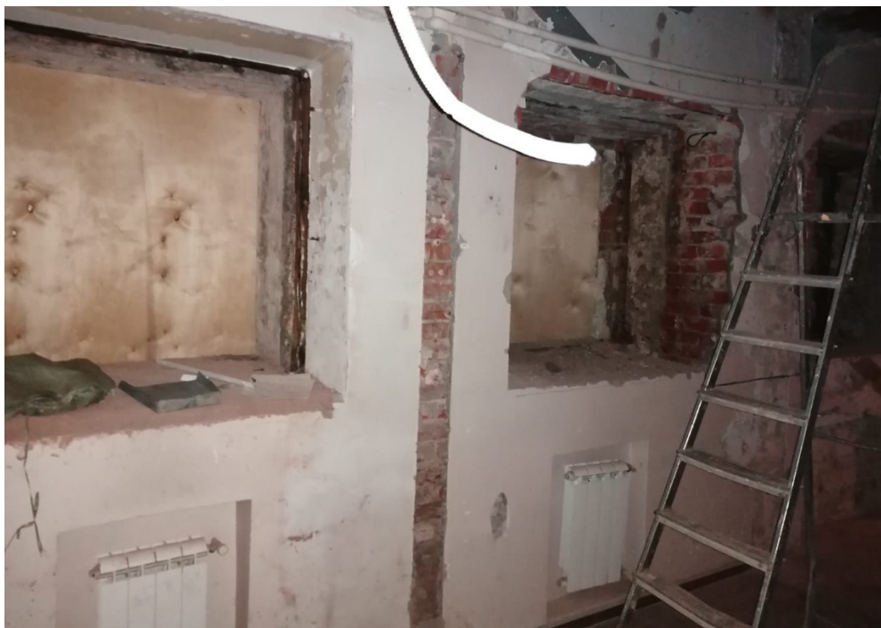
Фото 7. Цокольное помещение. Проемы
