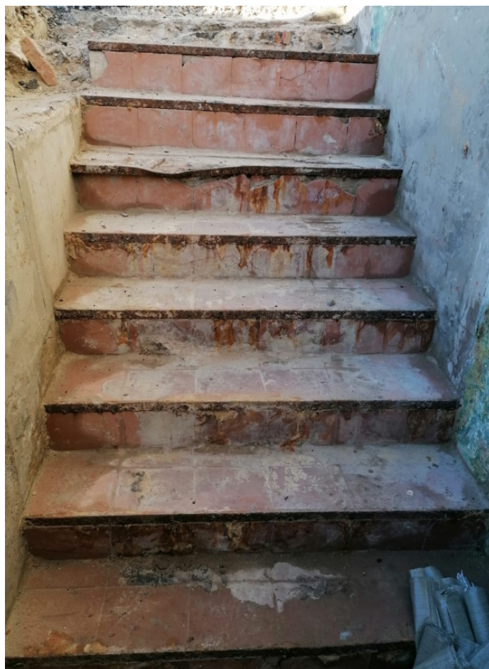
Фото 5. Выкопанный(существующий) вход в цоколь в осях 9-8, со стороны дворового фасада.
