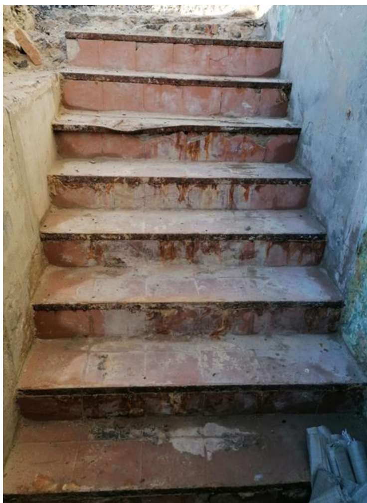
Выкопанный(существующий) вход в цоколь в осях 9-8, со стороны дворового фасада
