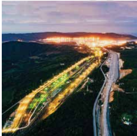
Восточный полигон, Дальневосточная ж/д
