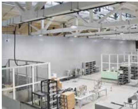
Обшивка стен профнастилом в цехе № 110
