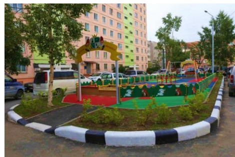
Ремонт дворов и внутриквартальных проездов
