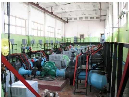
Выполнены работы по техническому перевооружению ПС-7
