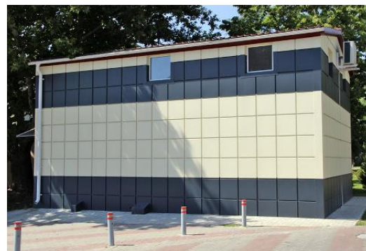
Строительство станции биологической очистки сточных вод на реке Су-Аран
