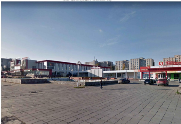
Фото существующего положения вид 1
