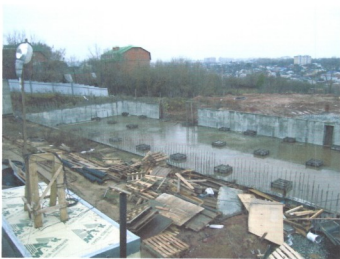
Фото 2. Монолитная фундаментная плита в осях (3-10)
