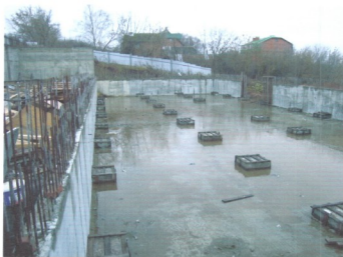
Фото 4. Монолитная фундаментная плита
