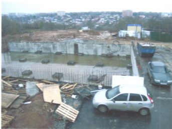
Фото 3. Монолитная фундаментная плита в осях (1-5)
