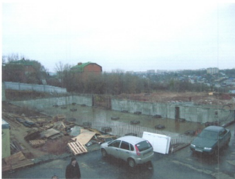
Фото 1. Общий вид на объект обследования
