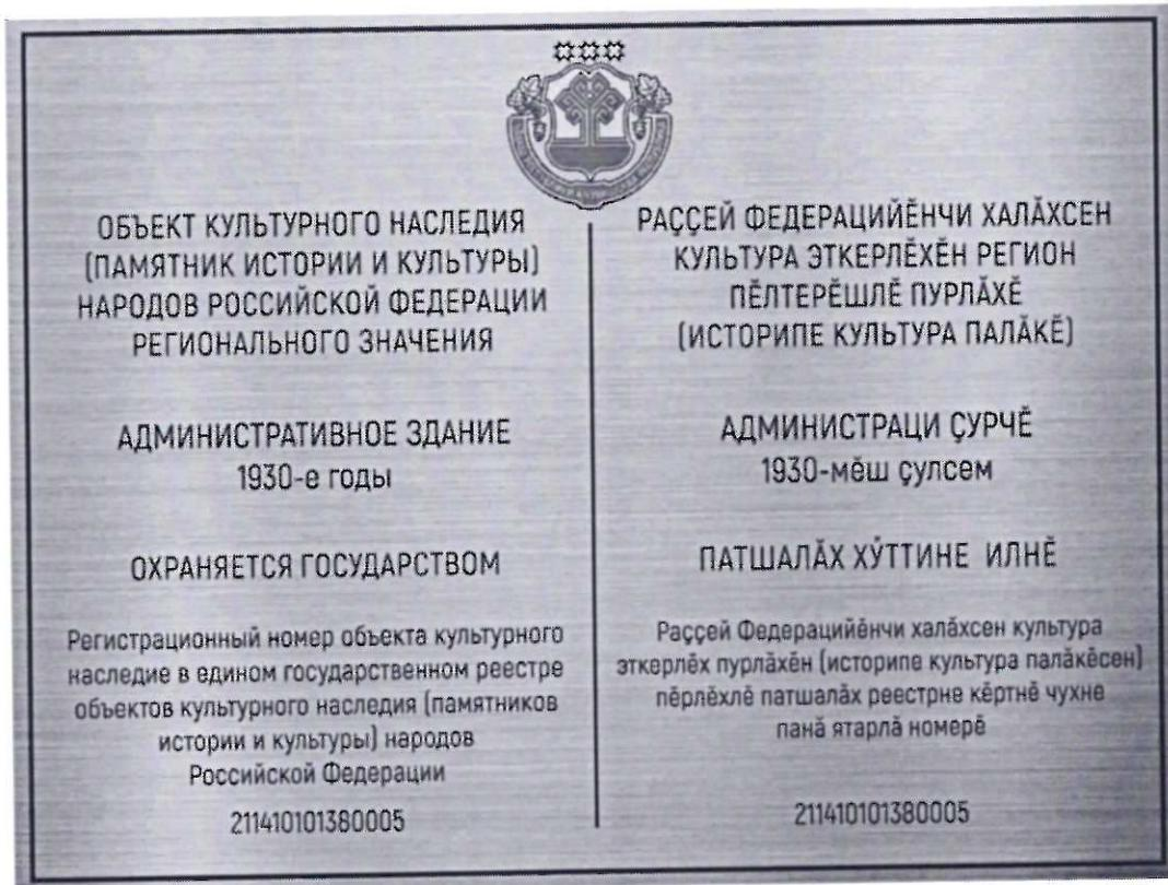
Информационная надпись располагается на фасаде угла здания на уровень первого этажа, между окнами. Изготавливается в виде пластины из композитного материала габаритным размером 800x600 мм. Надпись об объекте культурного наследия наносится методом прямой УФ печати на композитный материал, шрифт - Akrobat SemiBold, размере шрифта 63п.
