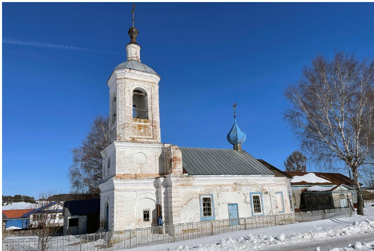
Фото 2. Общий вид на выявленный объект культурного наследия в северном направлении.
