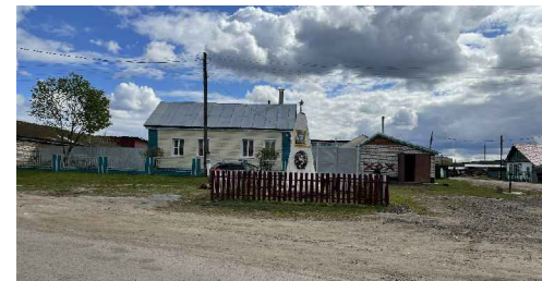
Общий вид с севера
