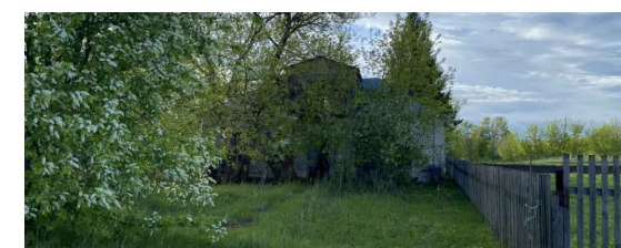
Южный фасад ОКН
