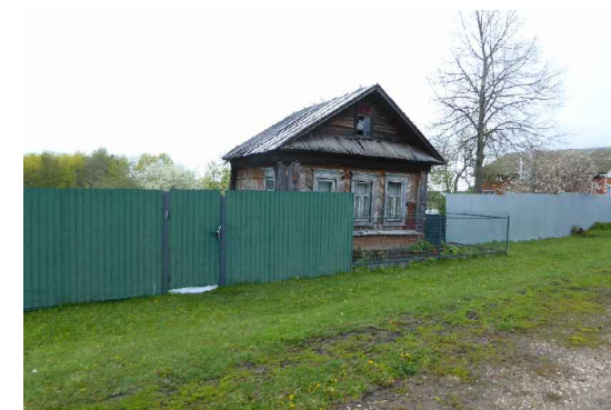
Общий вид ОКН с юго-запада, перекрытый диссонирующим забором
