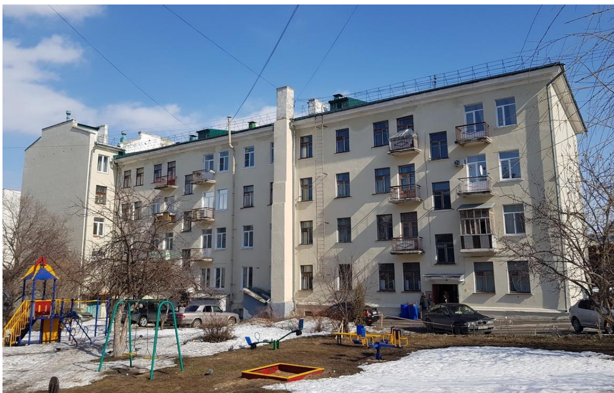
Фото № 3. Дворовый фасад объекта, обладающего признаками объекта культурного наследия, 2019 г.
