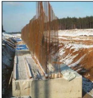
Устройство монолитного ж/б фундамента
