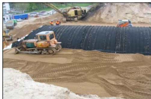
Укладка геотекстильного материала, устройство грунтового конверта с послойным уплотнением
