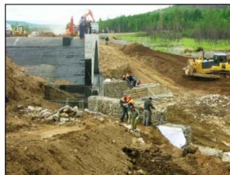
Укладка габионных стенок
