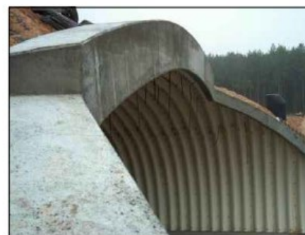
Устройство порталной стенки / шапчного бруса
