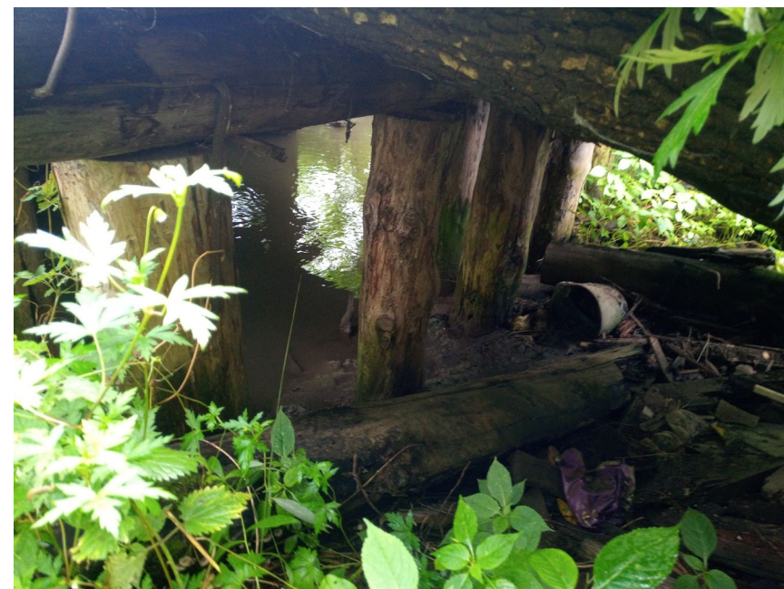
Аварийное состояние существующего моста
