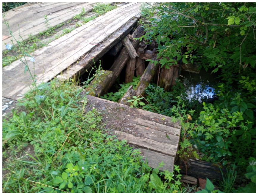
Аварийное состояние существующего моста
