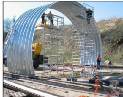
Сборка гофрированных листов при помощи болтовых соединений
