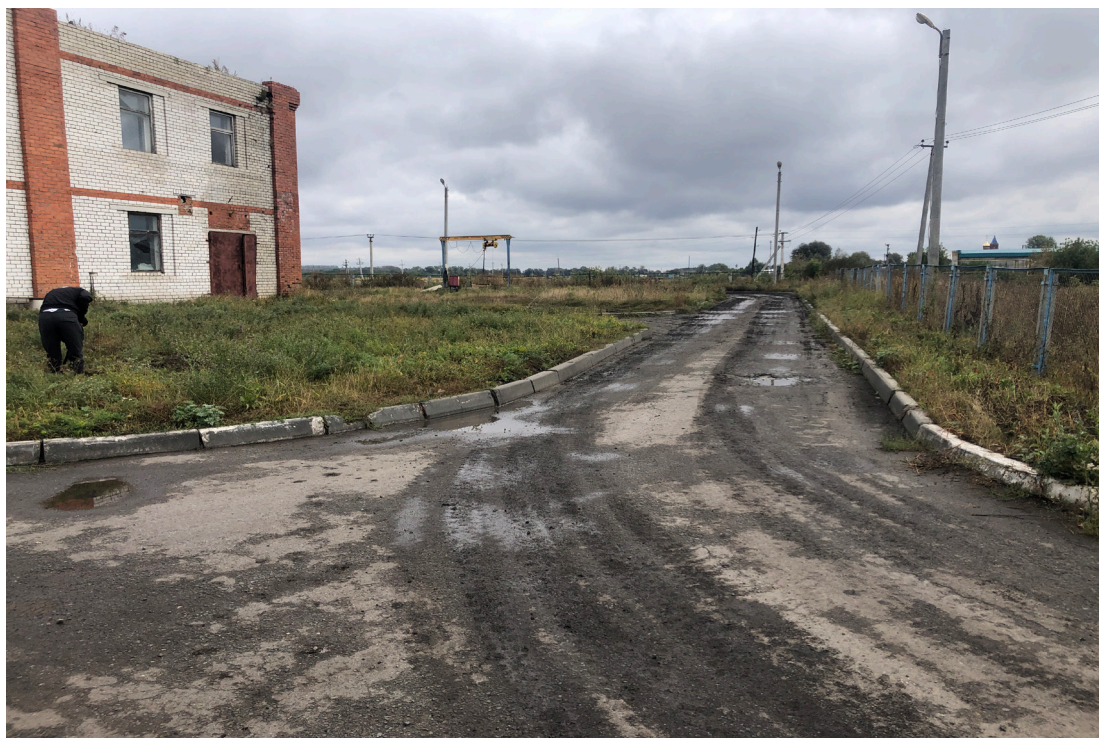
Рис. 11. «Реконструкция канализационных очистных сооружений по ул. Дружба д. 30 в с. Батырево Батыревского района Чувашской республики». Вид из тф 2 на 3.
