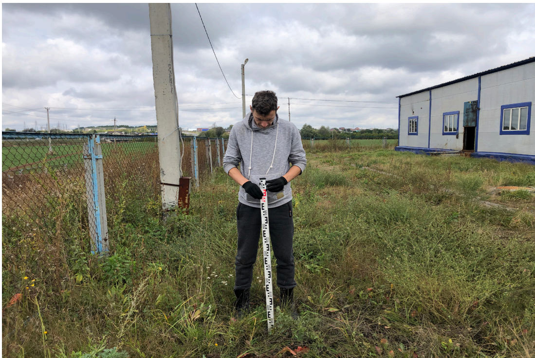
Рис. 17. «Реконструкция канализационных очистных сооружений по ул. Дружба д. 30 в с. Батырево Батыревского района Чувашской республики». Вид с Ю на разбивку шурфа 2.
