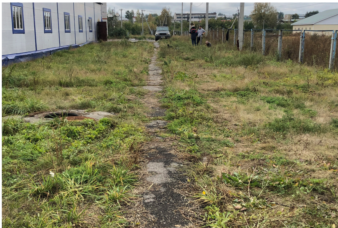
Рис. 12. «Реконструкция канализационных очистных сооружений по ул. Дружба д. 30 в с. Батырево Батыревского района Чувашской республики». Вид из тф 3 на С.
