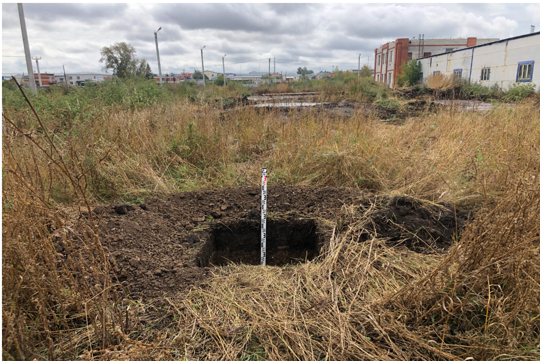
Рис. 15. «Реконструкция канализационных очистных сооружений по ул. Дружба д. 30 в с. Батырево Батыревского района Чувашской республики». Общий вид с С на шурф 1.
