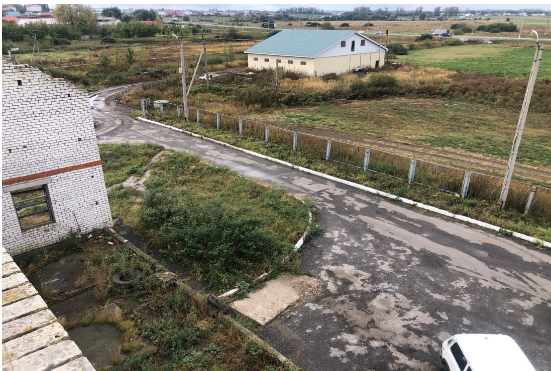
Рис. 10. «Реконструкция канализационных очистных сооружений по ул. Дружба д. 30 в с. Батырево Батыревского района Чувашской республики». Вид из тф 1 на З.
