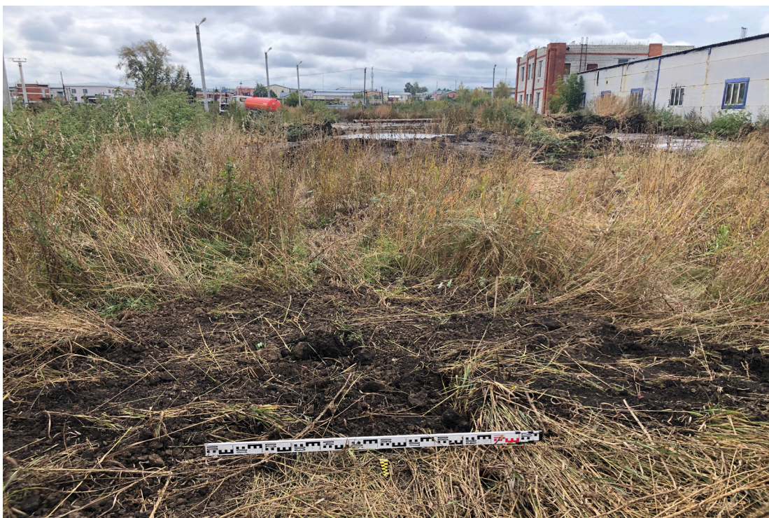
Рис. 16. «Реконструкция канализационных очистных сооружений по ул. Дружба д. 30 в с. Батырево Батыревского района Чувашской республики». Вид с С на рекультивацию шурфа 1.
