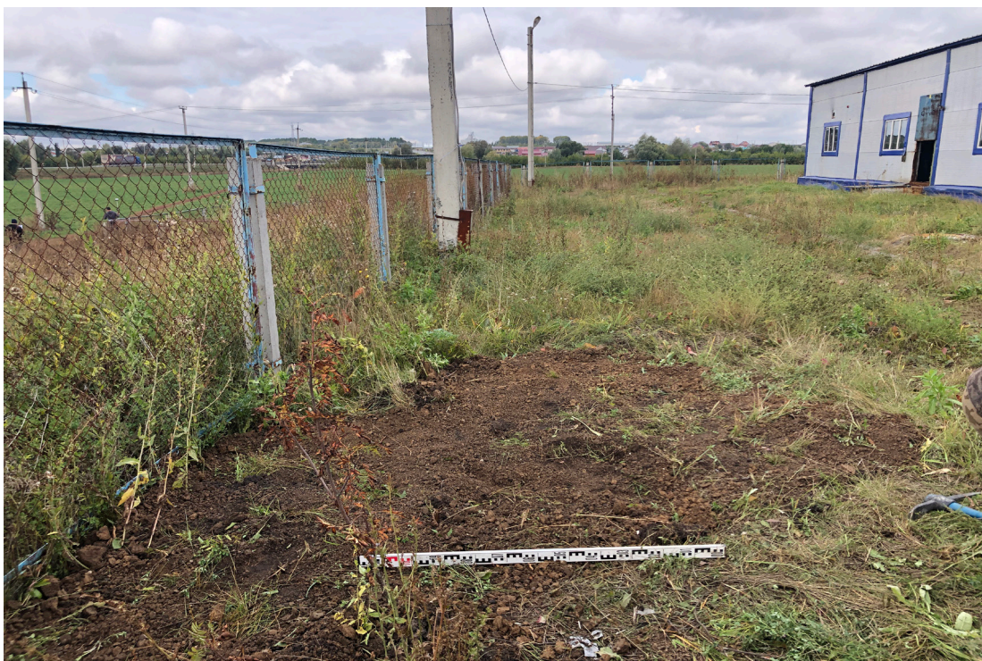
Рис. 20. «Реконструкция канализационных очистных сооружений по ул. Дружба д. 30 в с. Батырево Батыревского района Чувашской республики». Вид с Ю на рекультивацию шурфа 2.
