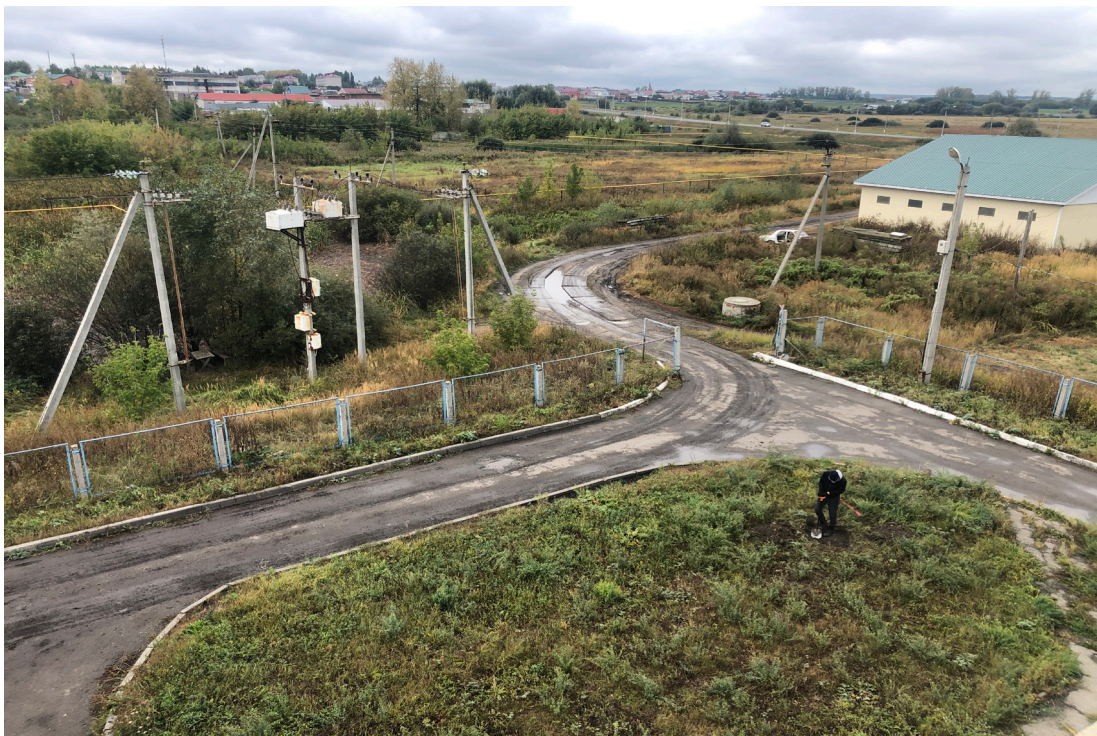
Рис. 7. «Реконструкция канализационных очистных сооружений по ул. Дружба д. 30 в с. Батырево Батыревского района Чувашской республики». Вид из тф 1 на ЮЗ.
