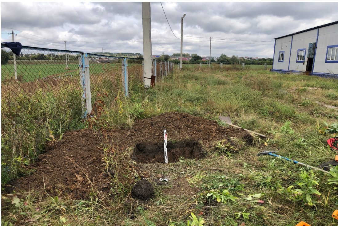
Рис. 19. «Реконструкция канализационных очистных сооружений по ул. Дружба д. 30 в с. Батырево Батыревского района Чувашской республики». Общий вид с Ю на шурф 2.
