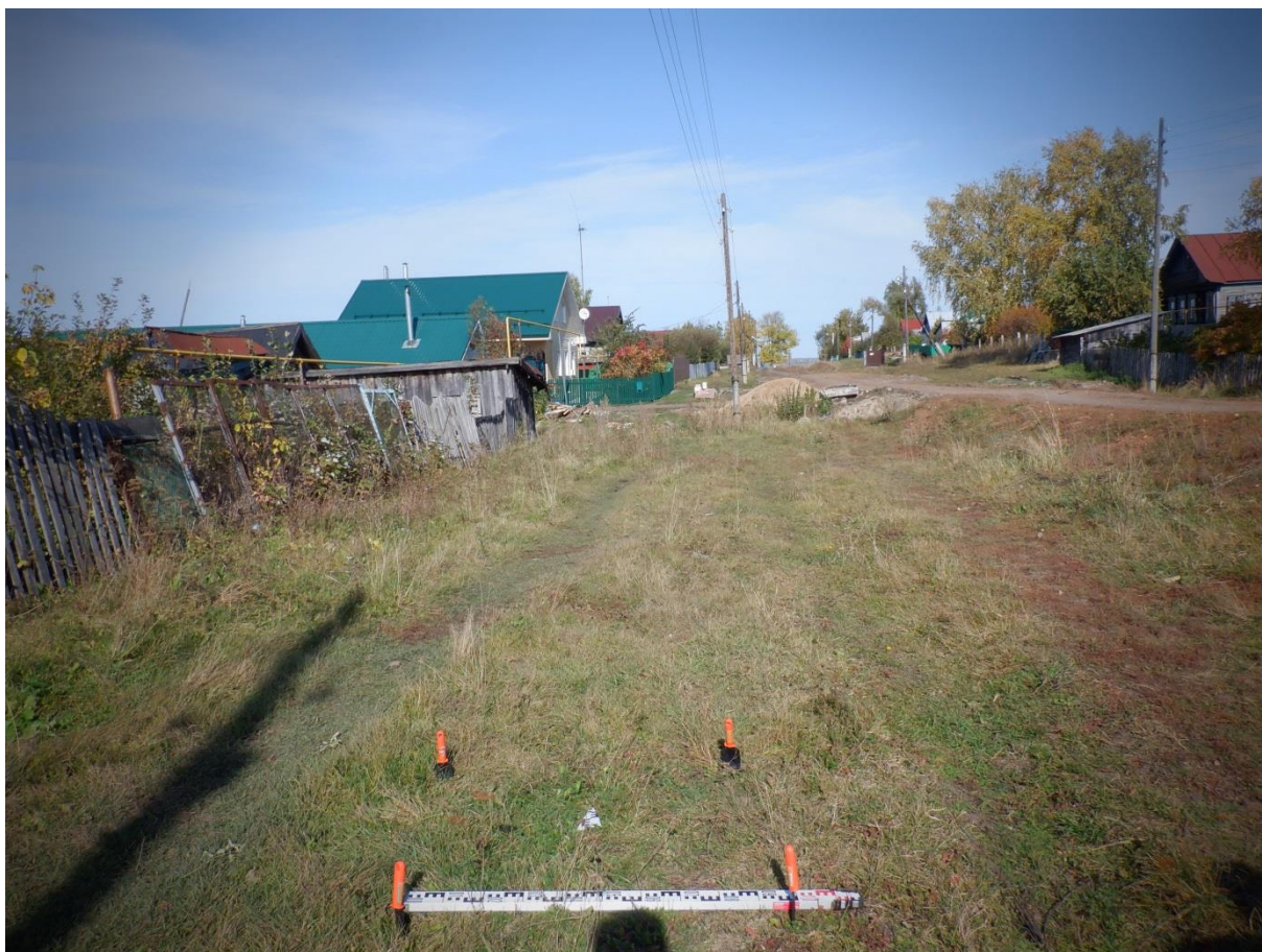
Илл. 16. Шурф 2 перед началом работ. Вид с Ю.
