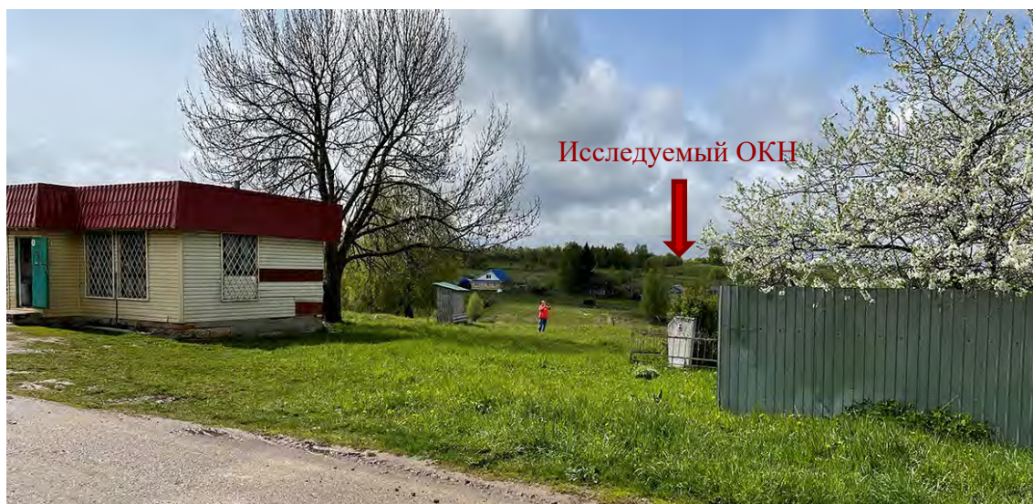
Вид на исследуемый ОКН в юго-западном направлении с ул. Шоссейной. Слева – здание магазина, неадаптированное к характеру историко-градостроительной среды
