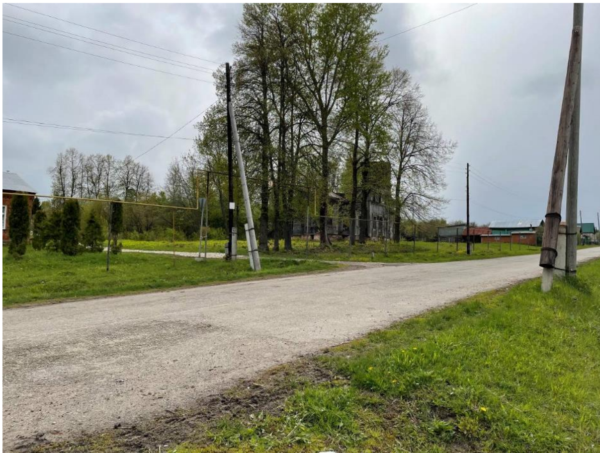
Фото 13 Общий вид исследуемого ОКН с северо-запада
