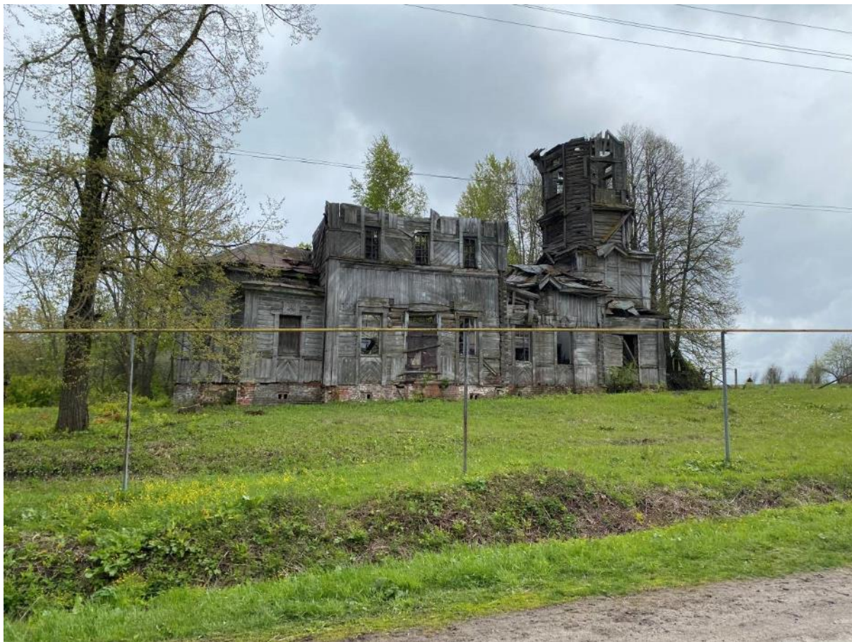
Фото 5 Общий вид исследуемого ОКН в южном направлении, с проезжей части ул. Советской
