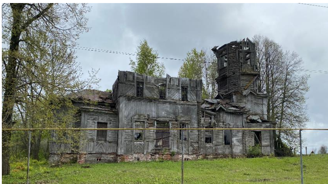
Общий вид ОКН с северо-запада
