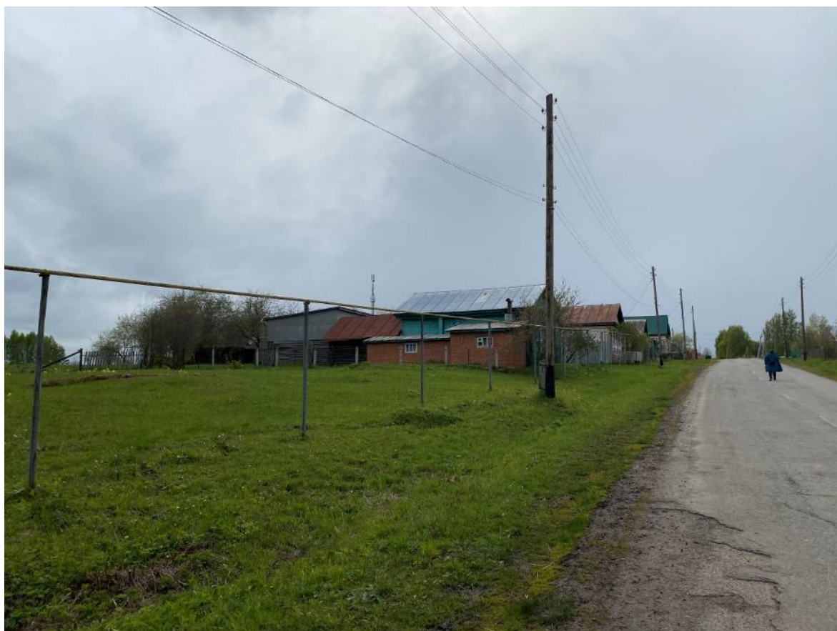
Фото 3 Перспективный вид четной стороны застройки ул. Советской в западном направлении, от исследуемого ОКН
