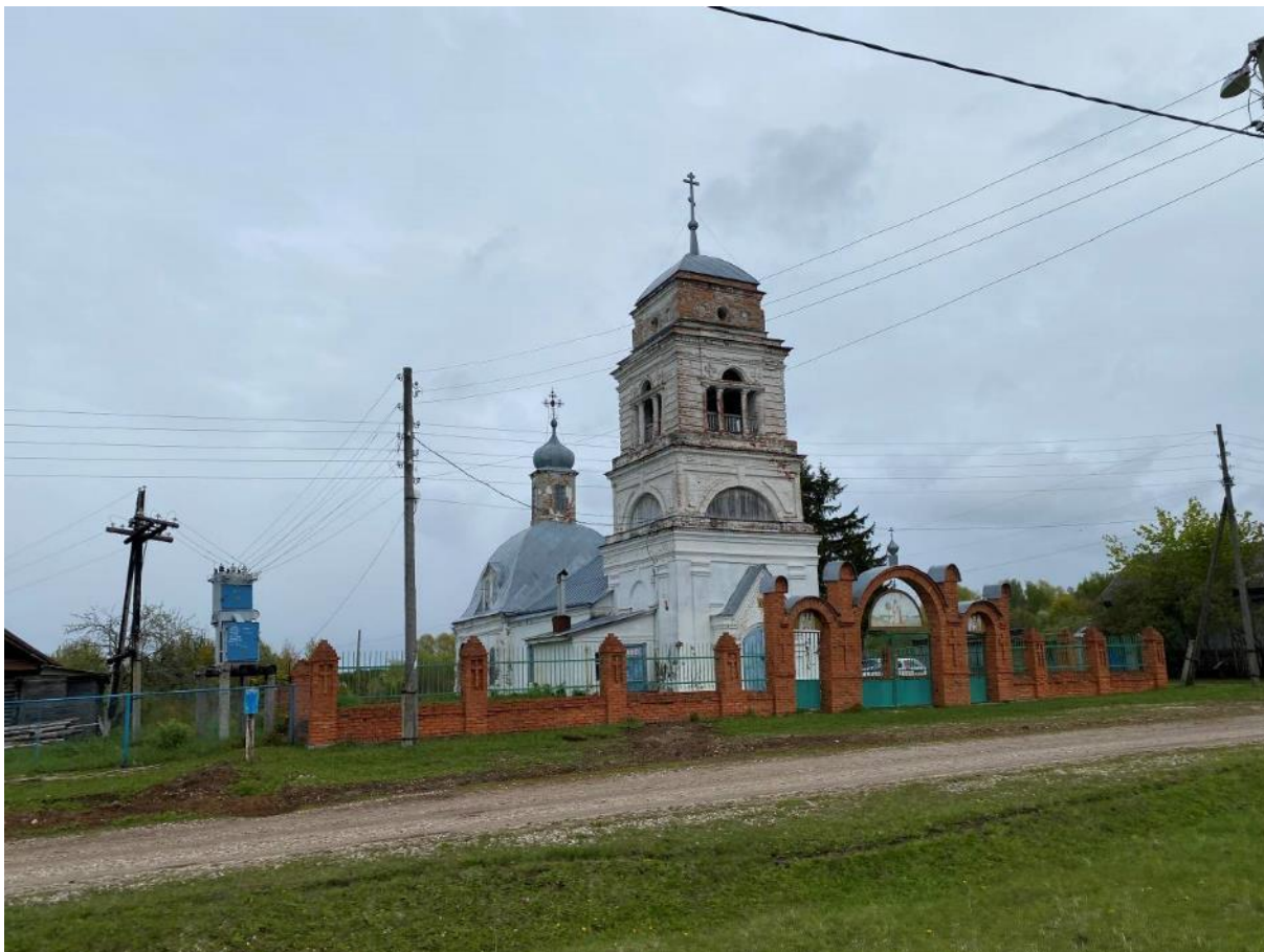
Фото 13 Общий вид исследуемого ОКН «Троицкая церковь», XVIII в., с северо-запада
