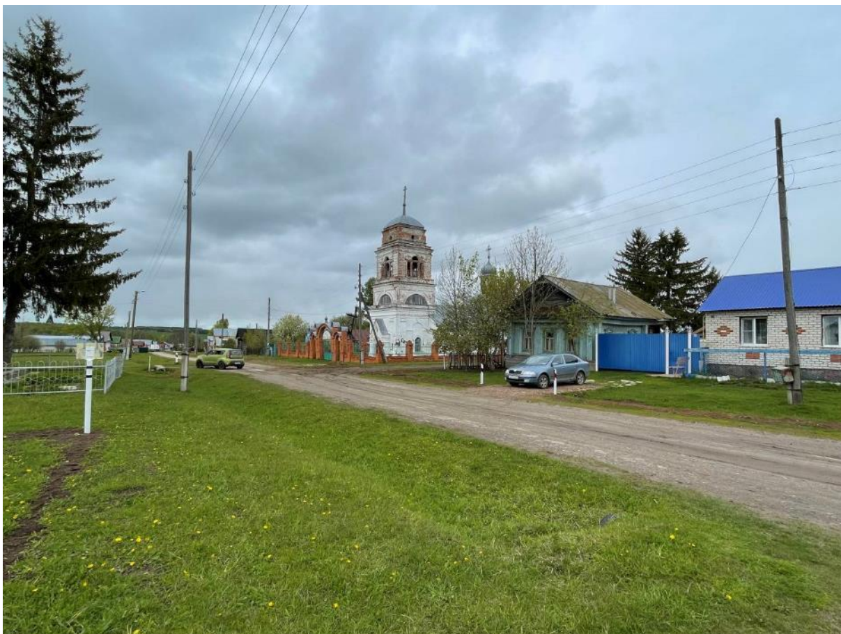
Фото 6 Общий вид исследуемого ОКН «Троицкая церковь», XVIII в., с юго-запада, в районе домовладений под №№ 39
