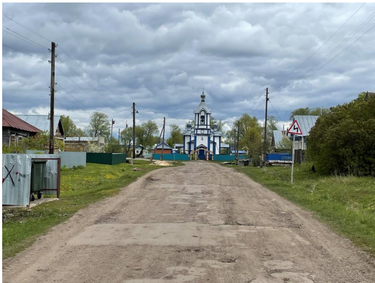
Фото 20 Вид на исследуемый ОКН в створе ул. Кузьмина
