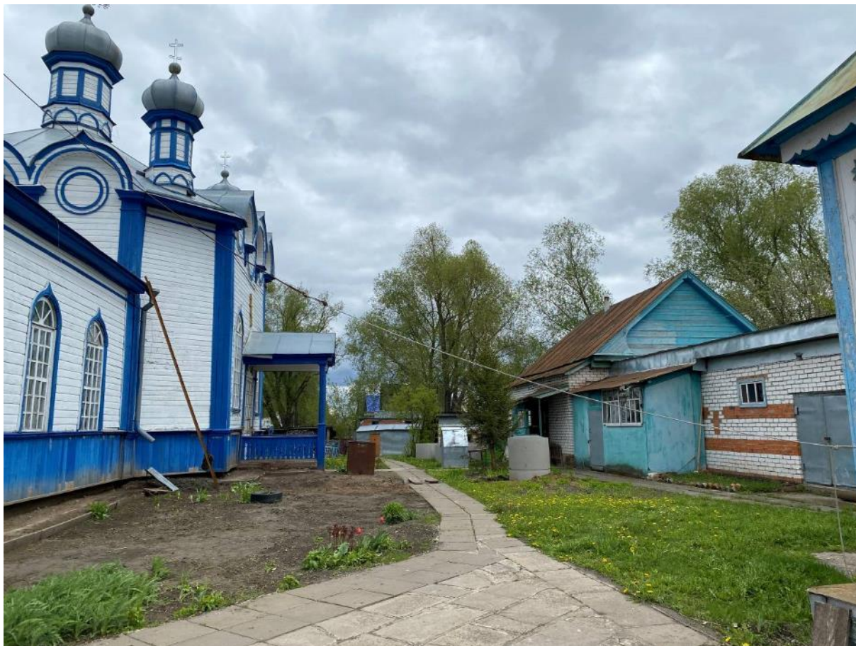
Фото 37 Общий вид построек на участке церкви в восточном направлении
