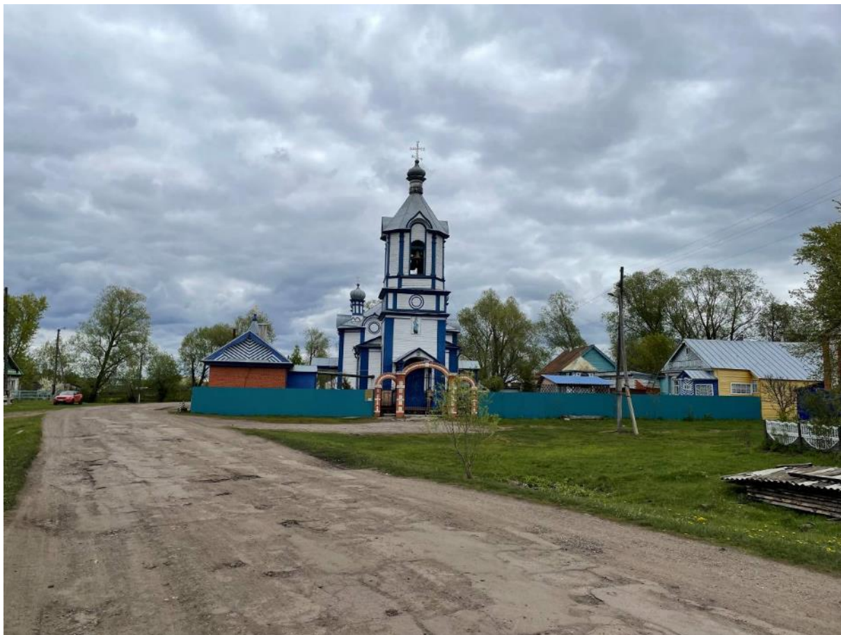
Фото 21 Общий вид исследуемого ОКН с запада
