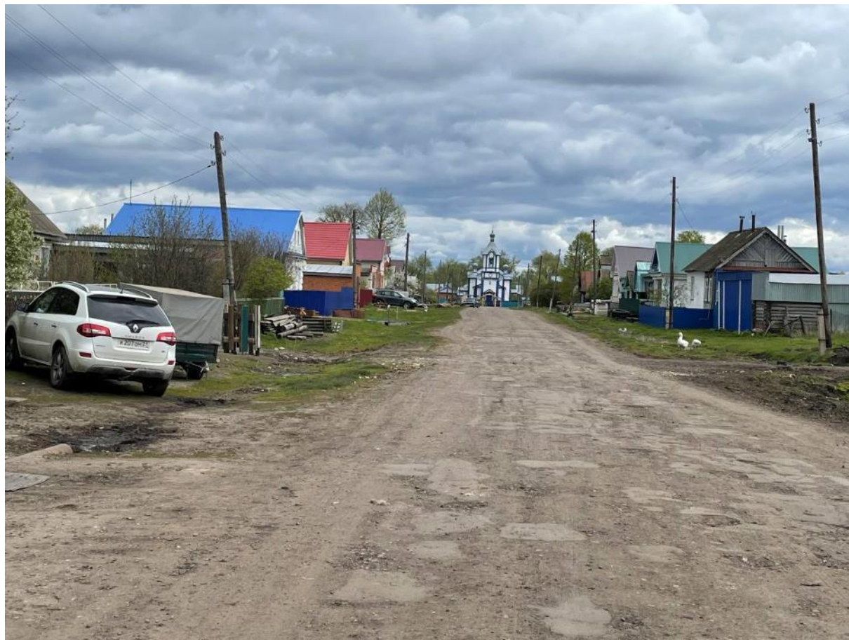
Фото 15 Вид на исследуемый ОКН в створе ул. Кузьмина
