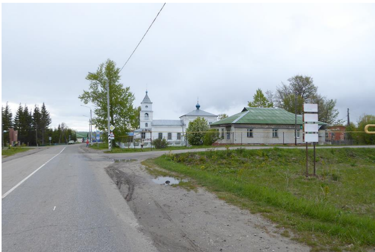
Фото 16 Общий вид ОКН «Успенская церковь (каменная)». Вид с юга, с ул. Советской, на расстоянии около 100 м от церкви
