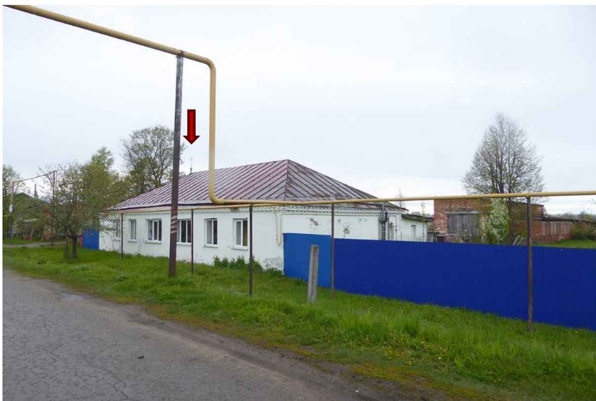
Фото 20 Одноэтажное здание по ул. Ленина, 1. Вид в северо-западном направлении в сторону ОКН «Успенская церковь (каменная)»
