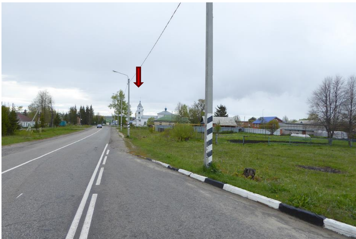
Фото 15 Общий вид ОКН «Успенская церковь (каменная)». Вид с юга, с ул. Советской, на расстоянии около 200 м от церкви
