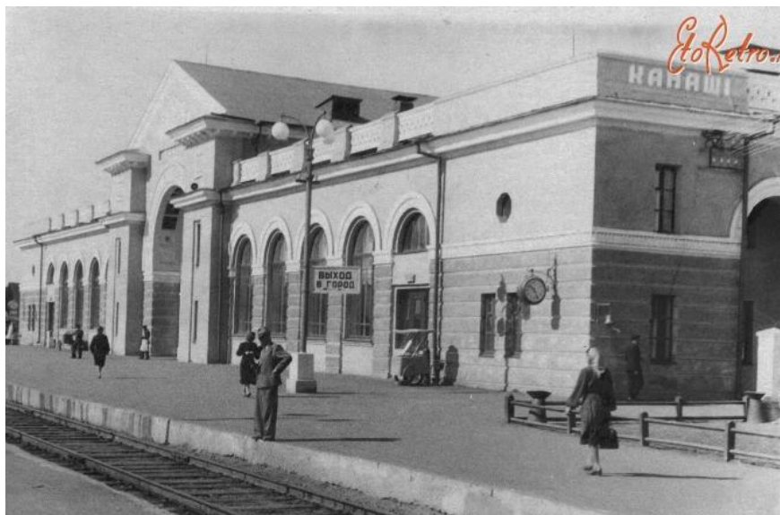
Рис. 9. Общий юго-западный вид здания вокзала с перрона, 1955 г.
