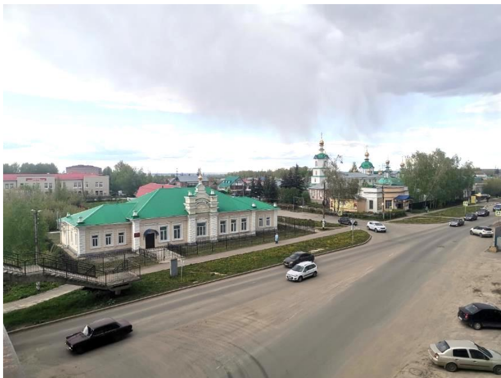
Общий вид исследуемого ОКН «Здание бывшей учительской семинарии», 1915 г., с пешеходного моста через железнодорожные пути, с юга.
