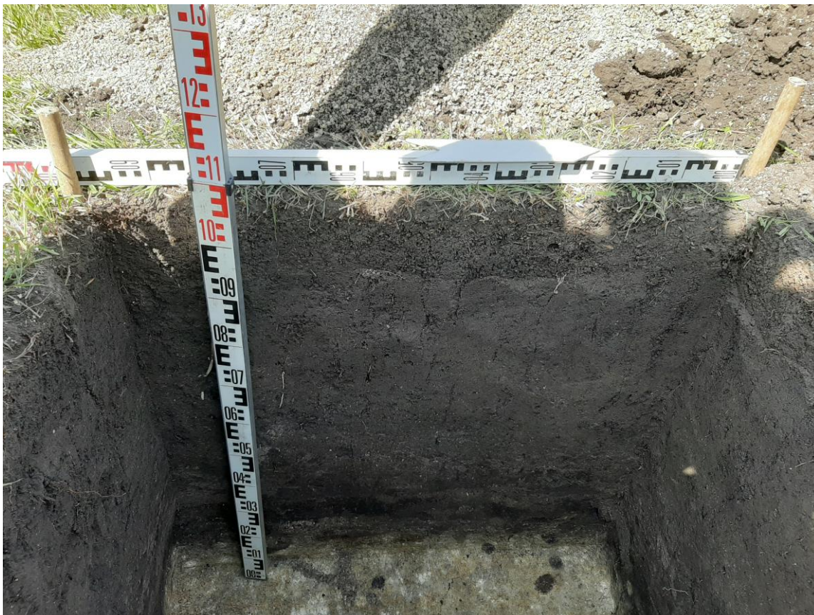
Илл. 44. Шурф 1. Западный борт. Вид с востока.
