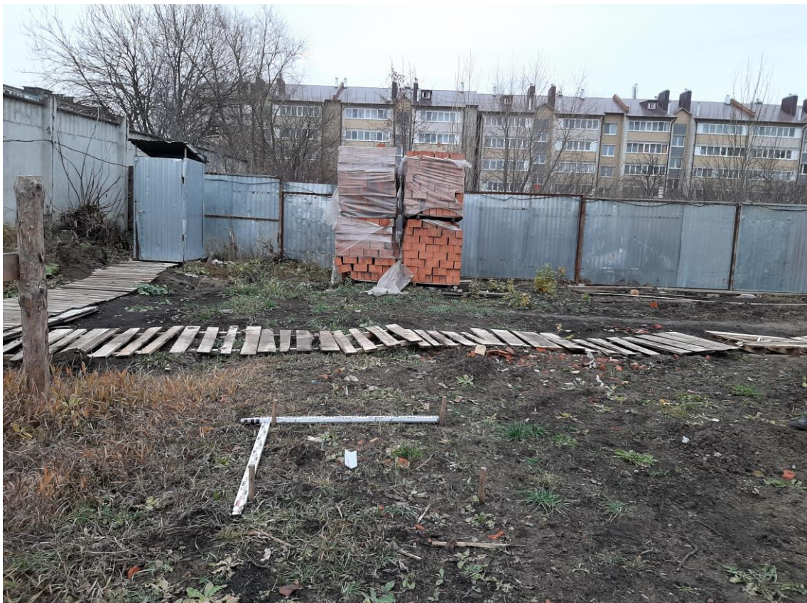
Илл. 13. Шурф 1 перед началом работ. Вид с севера.
