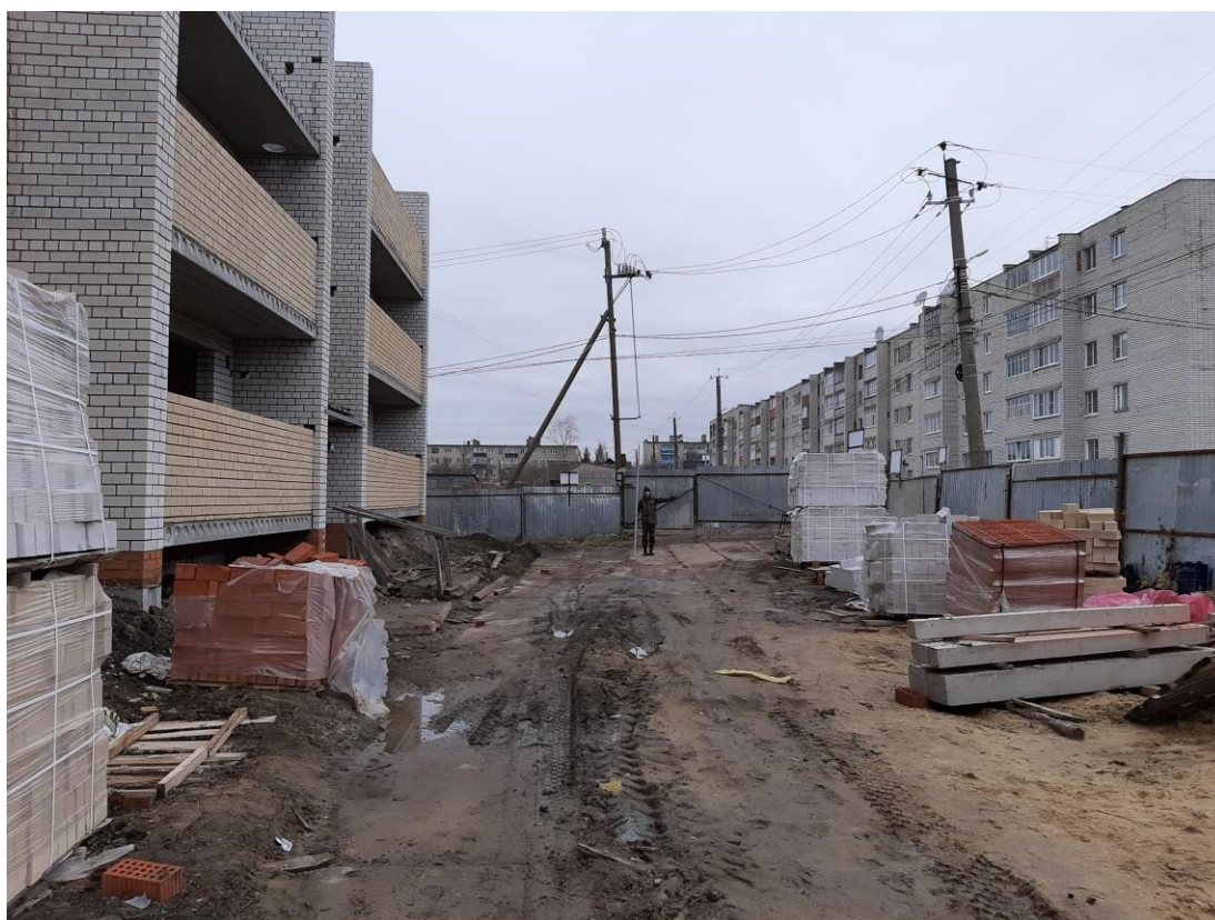
Илл. 12. Точка фотофиксации 3. Вид на обследованный земельный участок с востока.
