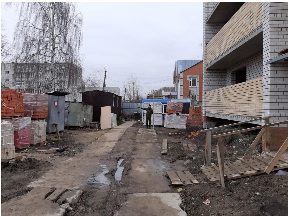
Илл. 11. Точка фотофиксации 3. Вид на обследованный земельный участок с запада.
