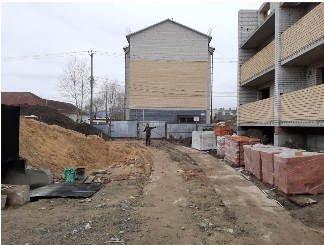
Илл. 9. Точка фотофиксации 2. Вид на обследованный земельный участок с востока.
