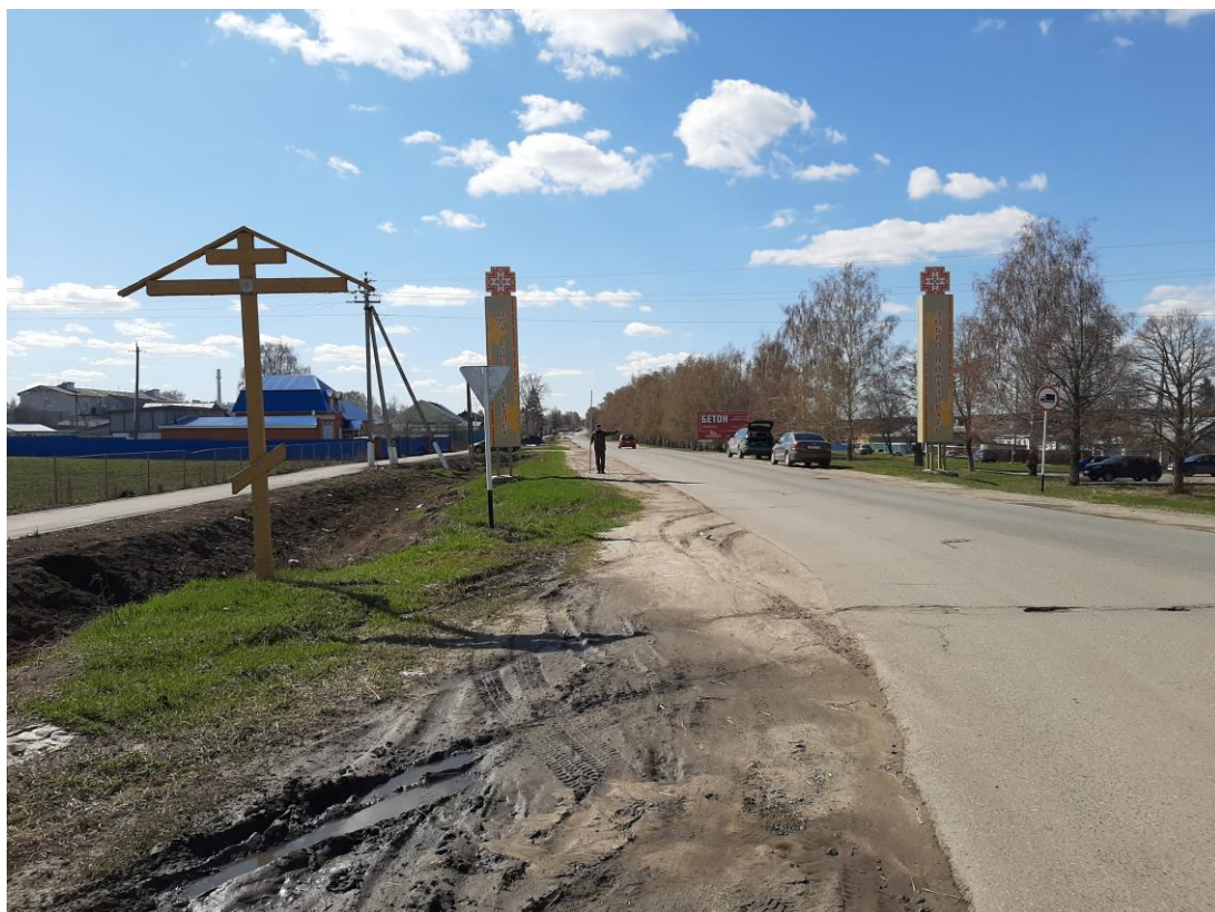
Илл. 28. Точка фотофиксации 8. Вид на обследованный земельный участок с востока.
