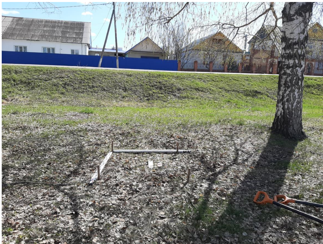
Илл. 52. Шурф 5 перед началом работ. Вид с севера.
