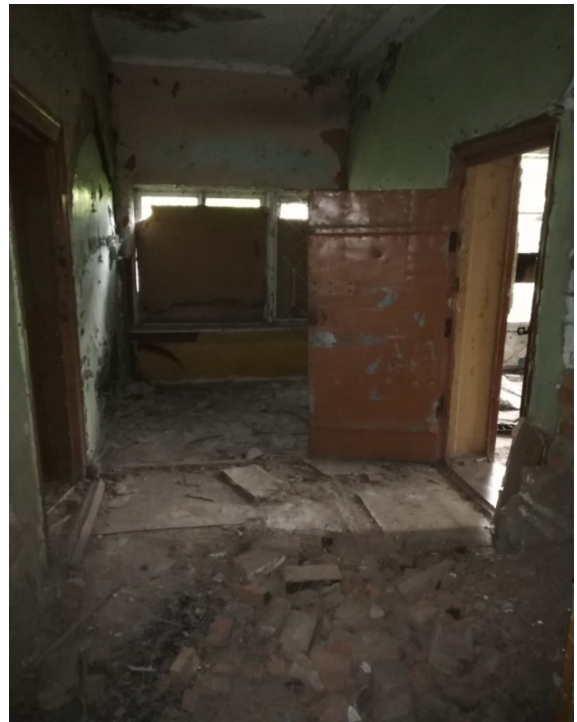
Дом Ашмарина, внутреннее состояние на 31.01.2020
