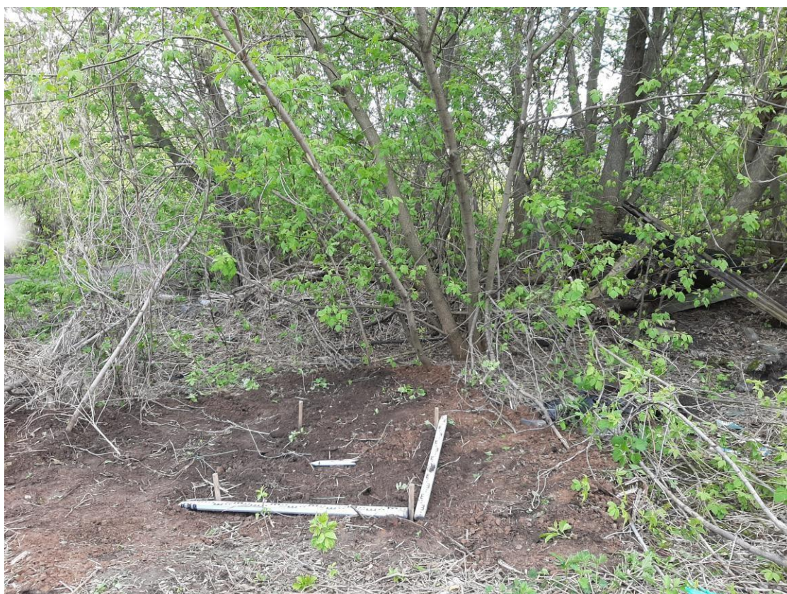
Илл. 25. Строительство дороги по улице Базарная от ул. Ильи Тукташа до ул. Дзержинского в микрорайоне 1А центральной части г. Чебоксары. Шурф 1 после рекультивации. Вид с запада.
