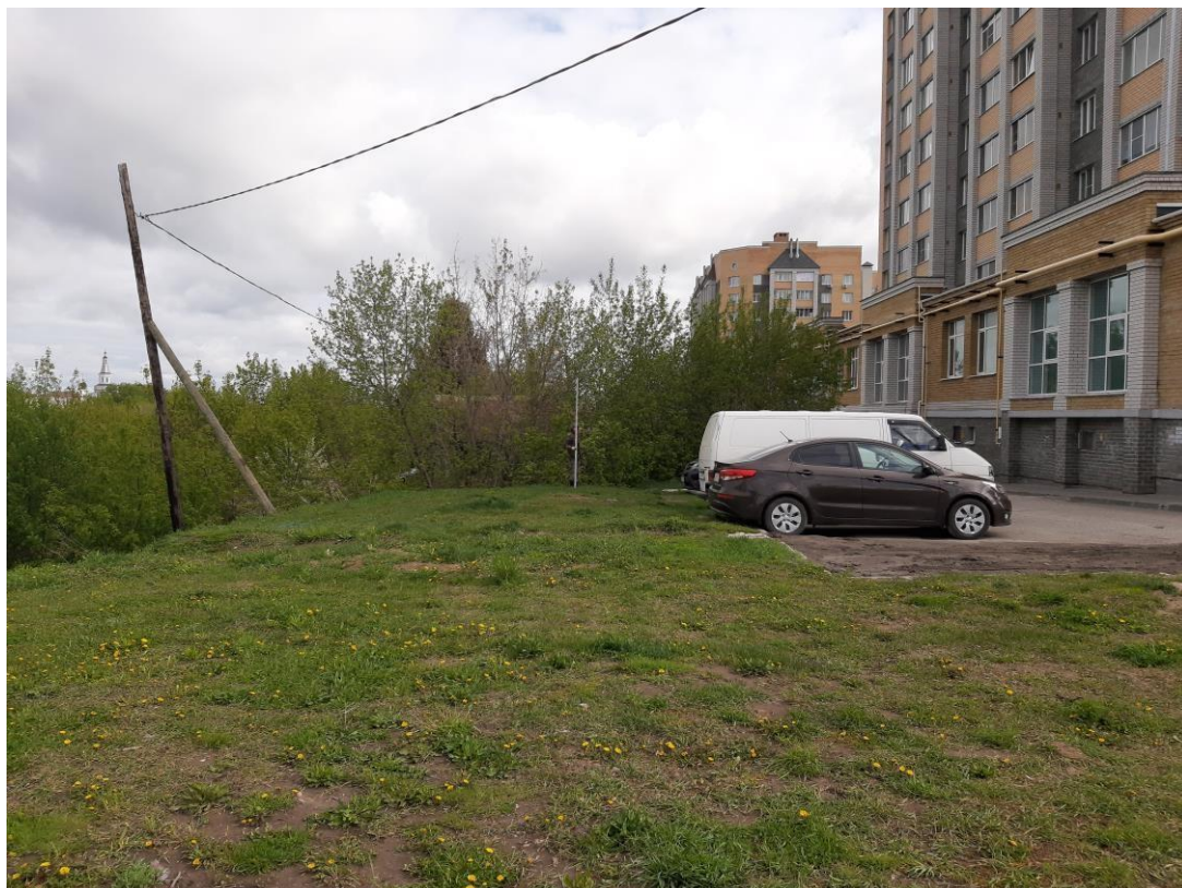
Илл. 32. Строительство дороги по улице Пушкина – Николая Смирнова в микрорайоне 1А центральной части г. Чебоксары. Точка фотофиксации 2. Вид на обследованный земельный участок с юго-юго-запада.
