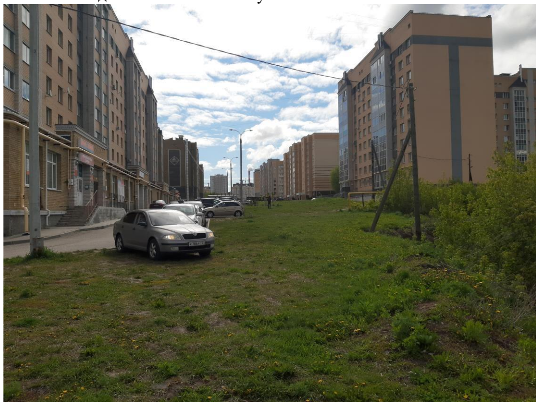
Илл. 31. Строительство дороги по улице Пушкина – Николая Смирнова в микрорайоне 1А центральной части г. Чебоксары. Точка фотофиксации 2. Вид на обследованный земельный участок с запада-северо-запада.
