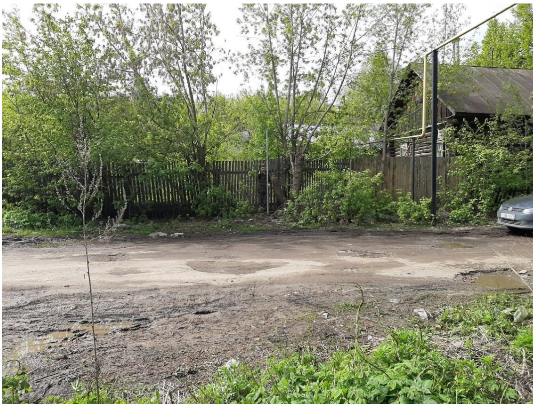
Илл. 12. Строительство дороги по улице Базарная от ул. Ильи Тукташа до ул. Дзержинского в микрорайоне 1А центральной части г. Чебоксары. Точка фотофиксации 4. Вид на обследованный земельный участок с севера.
