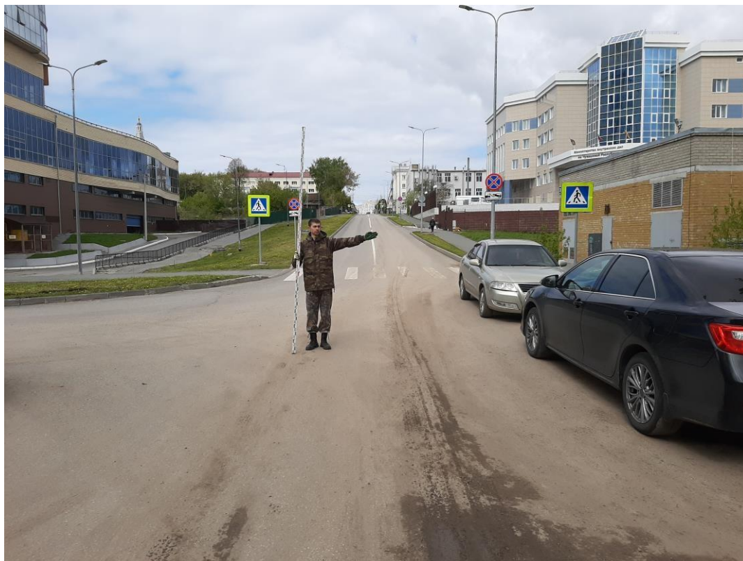
Илл. 22. Строительство дороги по улице Базарная от ул. Ильи Тукташа до ул. Дзержинского в микрорайоне 1А центральной части г. Чебоксары. Точка фотофиксации 10. Вид на обследованный земельный участок с востока.
