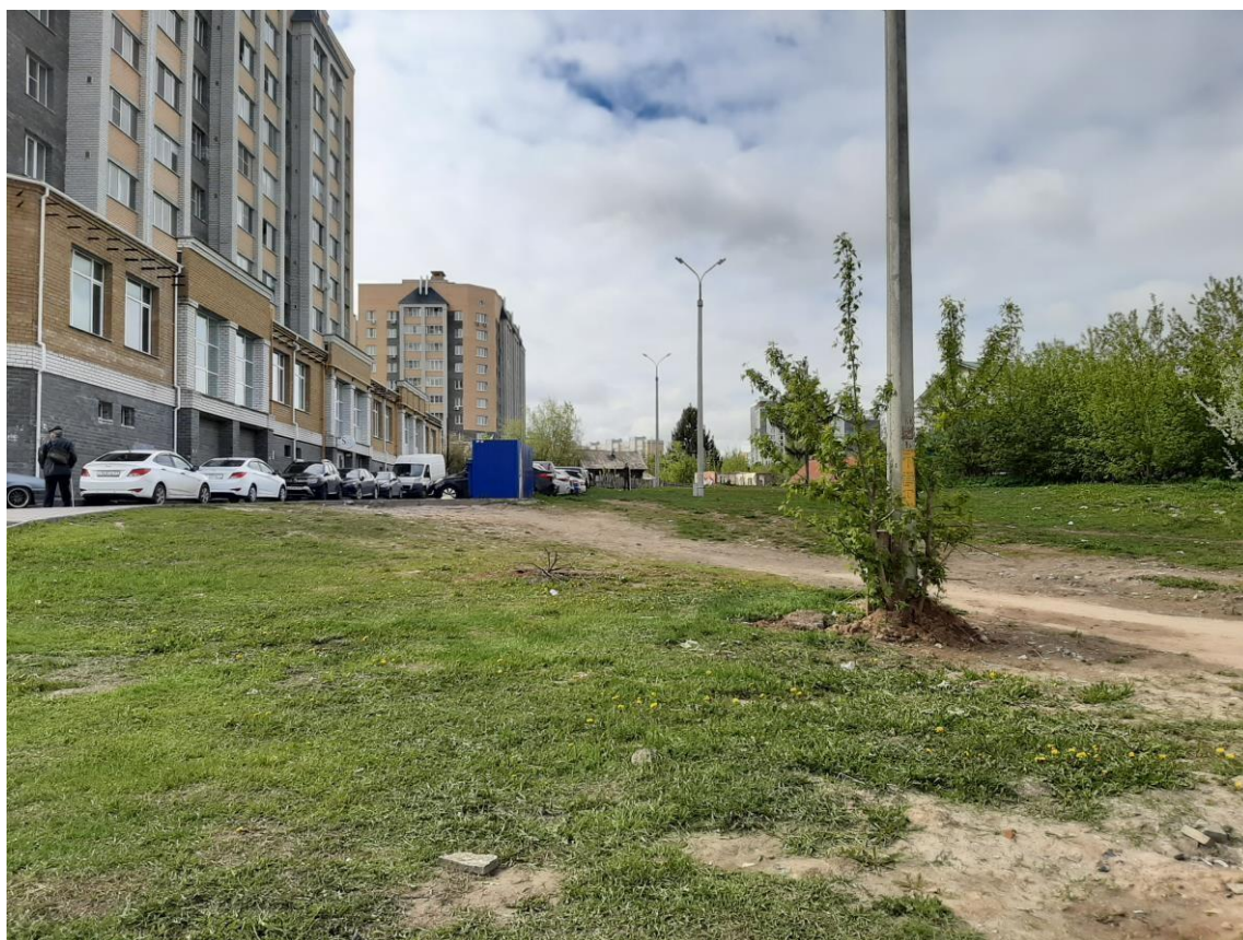
Илл. 38. Строительство дороги по улице Пушкина – Николая Смирнова в микрорайоне 1А центральной части г. Чебоксары. Точка фотофиксации 6. Вид на обследованный земельный участок с северо-северо-востока.
