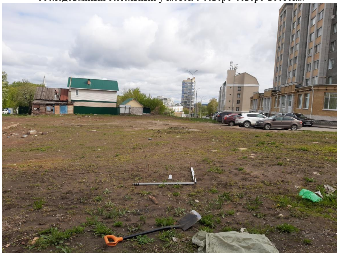
Илл. 39. Строительство дороги по улице Пушкина – Николая Смирнова в микрорайоне 1А центральной части г. Чебоксары. Шурф 1 перед началом работ. Вид с юга.
