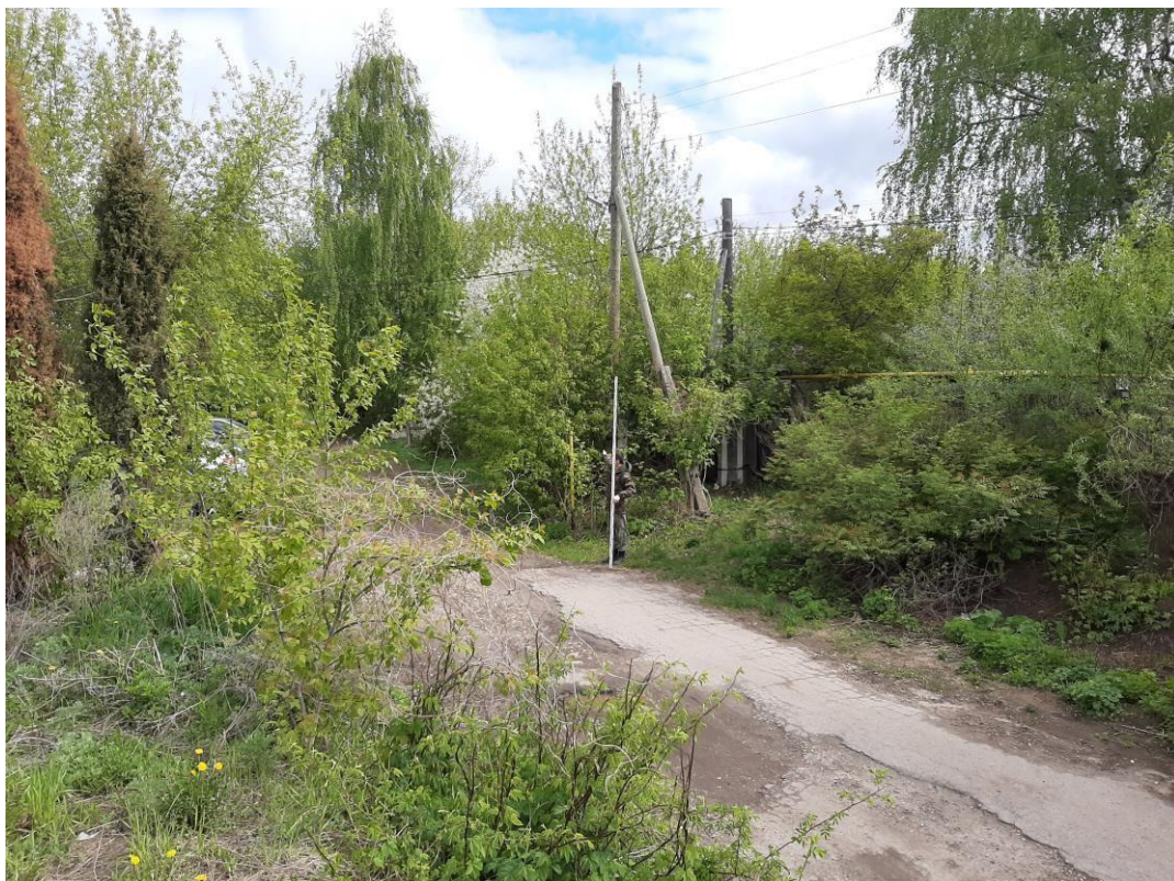
Илл. 8. Строительство дороги по улице Базарная от ул. Ильи Тукташа до ул. Дзержинского в микрорайоне 1А центральной части г. Чебоксары. Точка фотофиксации 1. Вид на обследованный земельный участок с юга.
