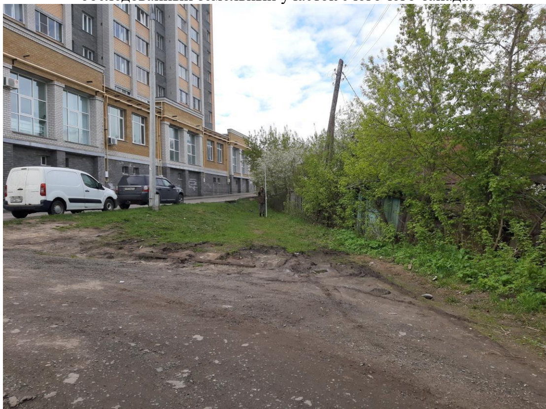
Илл. 33 Строительство дороги по улице Пушкина – Николая Смирнова в микрорайоне 1А центральной части г. Чебоксары. Точка фотофиксации 3. Вид на обследованный земельный участок с северо-северо-востока.
