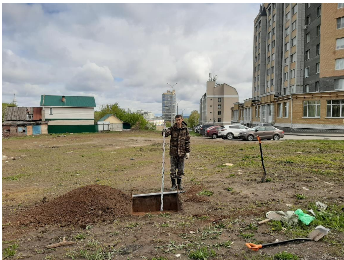
Илл. 40. Строительство дороги по улице Пушкина – Николая Смирнова в микрорайоне 1А центральной части г. Чебоксары. Шурф 1. Вид с юга.
