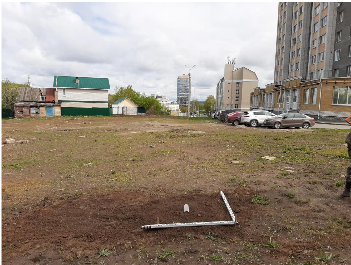
Илл. 42. Строительство дороги по улице Пушкина – Николая Смирнова в микрорайоне 1А центральной части г. Чебоксары. Шурф 1 после рекультивации. Вид с юга.
