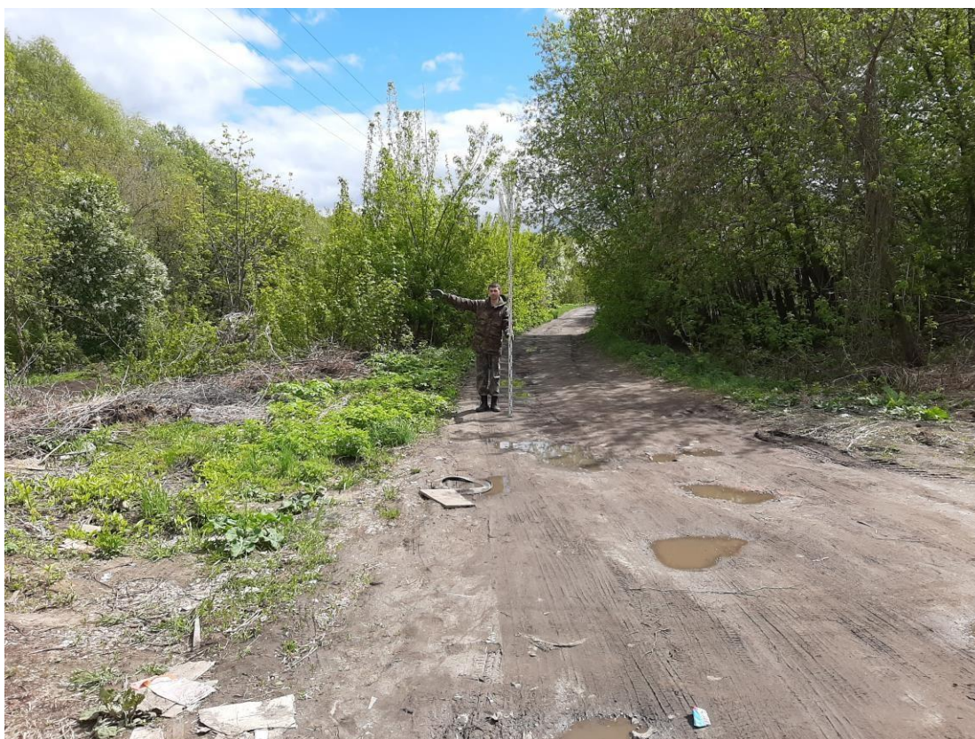
Илл. 19. Строительство дороги по улице Базарная от ул. Ильи Тукташа до ул. Дзержинского в микрорайоне 1А центральной части г. Чебоксары. Точка фотофиксации 9. Вид на обследованный земельный участок с запада-северо-запада.
