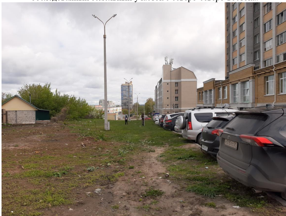
Илл. 37. Строительство дороги по улице Пушкина – Николая Смирнова в микрорайоне 1А центральной части г. Чебоксары. Точка фотофиксации 5. Вид на обследованный земельный участок с юго-юго-запада.
