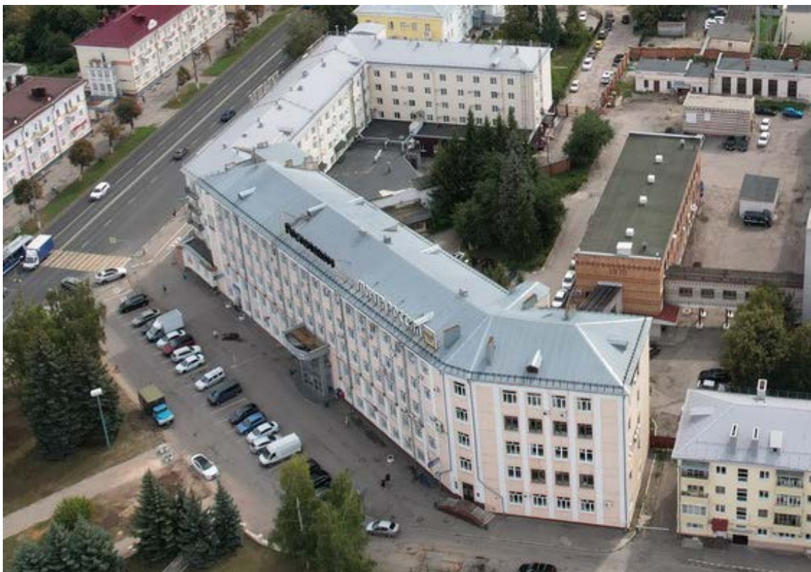
Фото 1. Общий вид Объекта.
