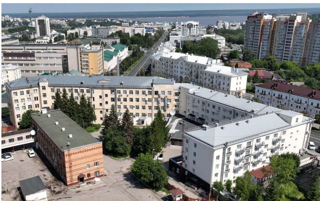
Фото 6. Общий вид дворового фасада.
