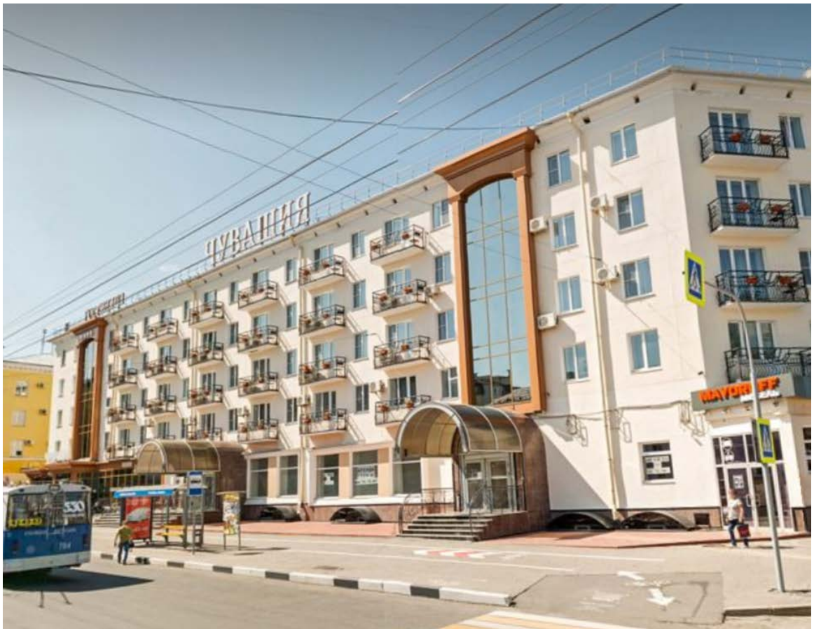
Фото 3. Общий вид здания. Корпус гостиницы «Чувашия».
