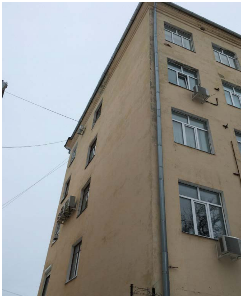
Фото 5. Торцевой фасад корпуса телеграфа.
