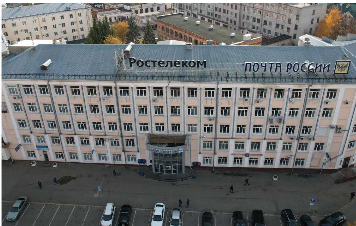
Фото 2. Общий вид объекта. Корпус телеграфа.
