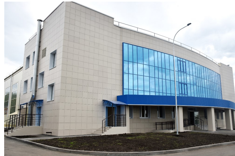
Строительство ФОК Ишлеи с 25-метровым плавательным бассейном
