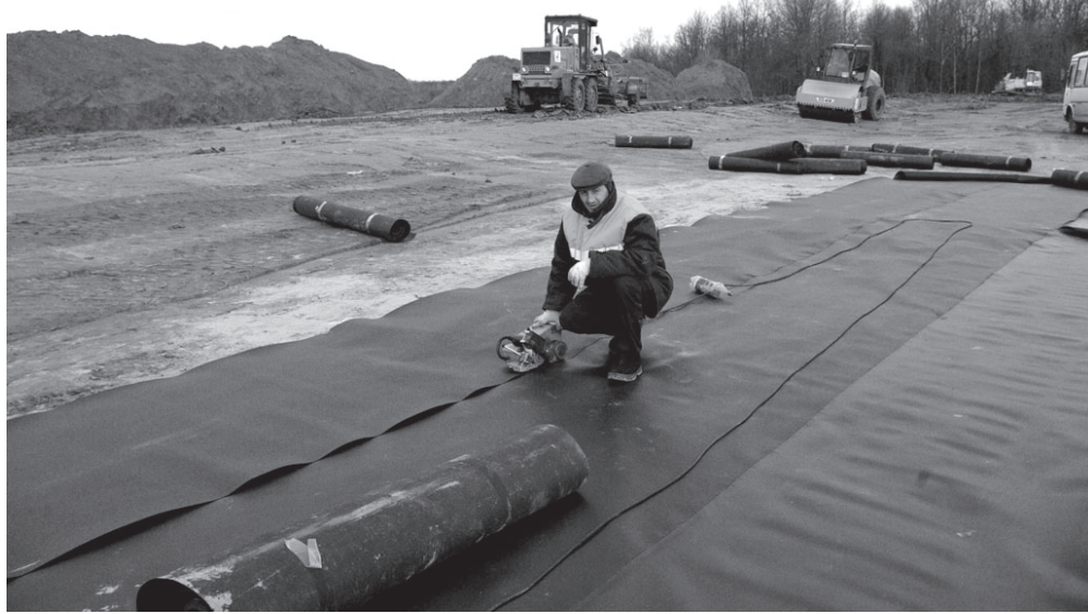
Котлован тәпне гидроизоляция материалә сарасәсә.
