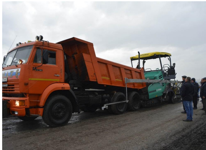
Ремонт автомобильной дороги «Яльчики – Новые Шимкусы»
