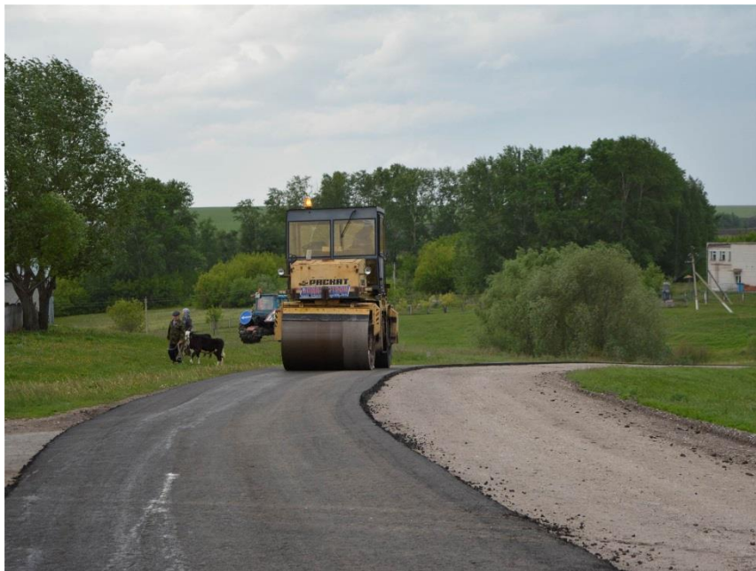
Ремонт автомобильной дороги «Комсомольское – Яльчики – Новые Шимкусы»
