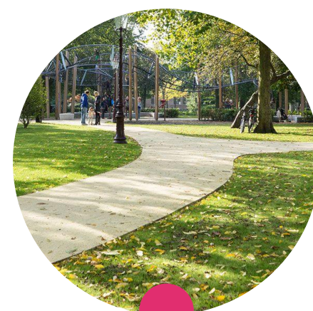
Бетонное покрытие 950 м 2
