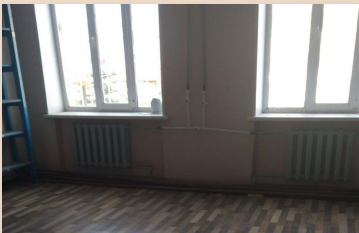
Архивохранилище муниципального архива Порецкого района Чувашской Республики после ремонта
